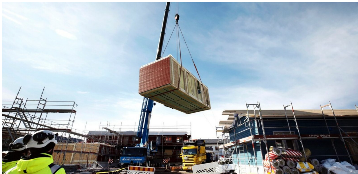
KUVA 6. Kuvaleike Rakennuslehden verkkosivulta Tilaelementtien asennusta työmaalla (Rakennuslehti, 2020)
