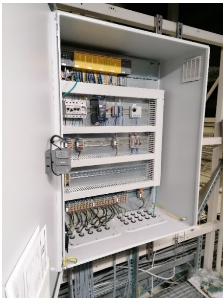
Kuva 21. Keskus paikalleen asennettuna
