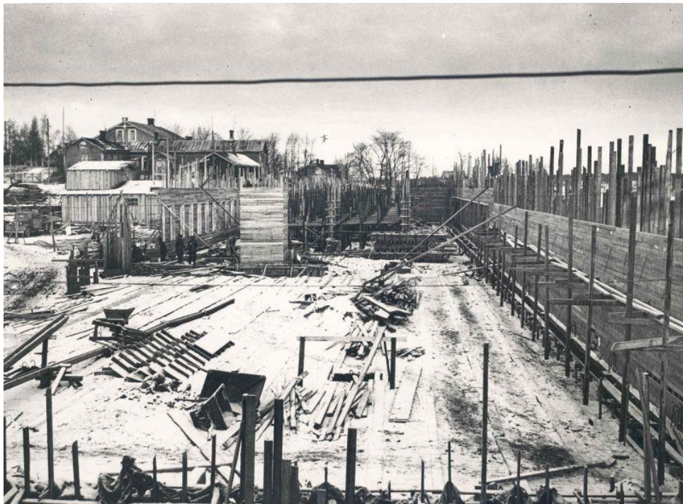
Kuva 57. Raunistulan tuotantolaitosten alue rakennustyömaana (Paldan, valokuvaaja 1943; Turun museokeskus).
