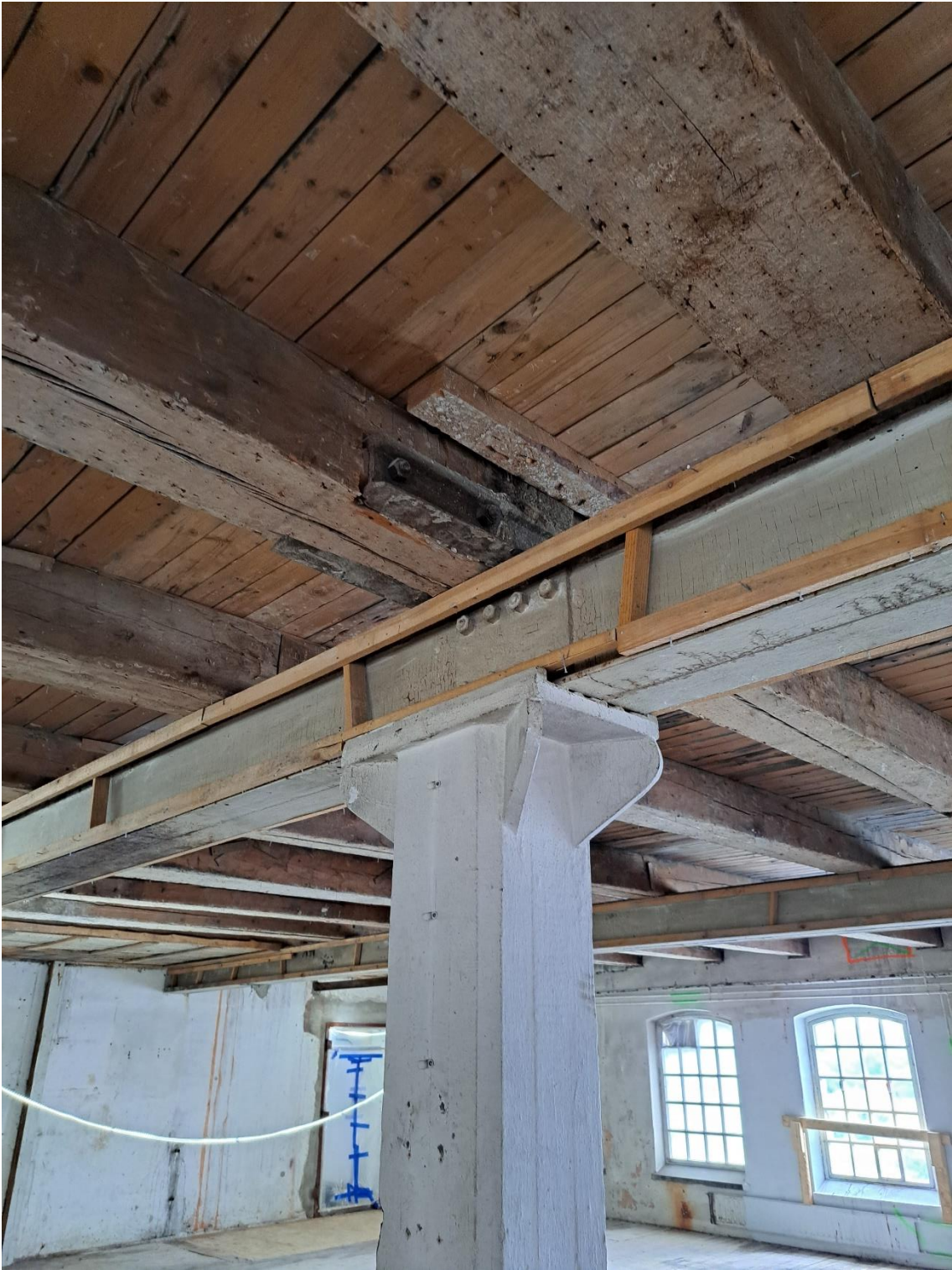
Kuva 37. F3-osan puuvälipohjan rakenteita.
