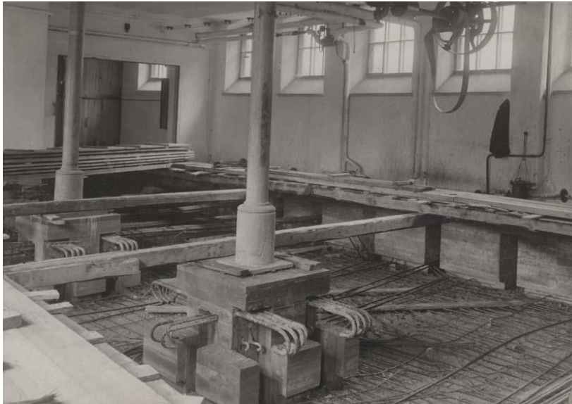
Kuva 26. Perustusten muutos- ja korjaustöitä vuonna 1922 (Gustaf Wellin 1922. Turun museokeskus).
