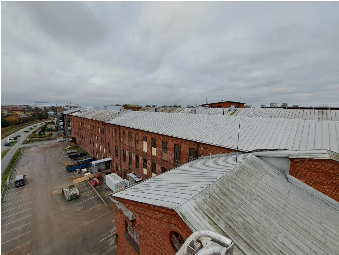
Kuva 45. Rakennuksen vesikattoja kuvattuna osan F6 etupuolelta.
