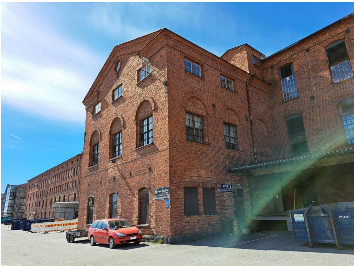
Kuva 42. Osa F6 ulkoa.
