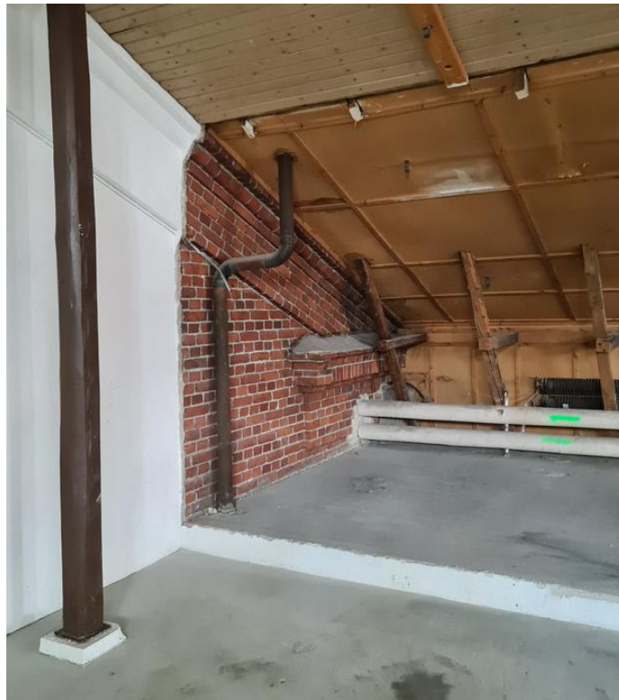
Kuva 44. Rakennuksen F3-osan pääty ja vanha ulkoseinä toimii nykyään väliseinänä. Näkyvissä myös räystäillä käytettyjä muototiiliä. Kuva osasta F14.
