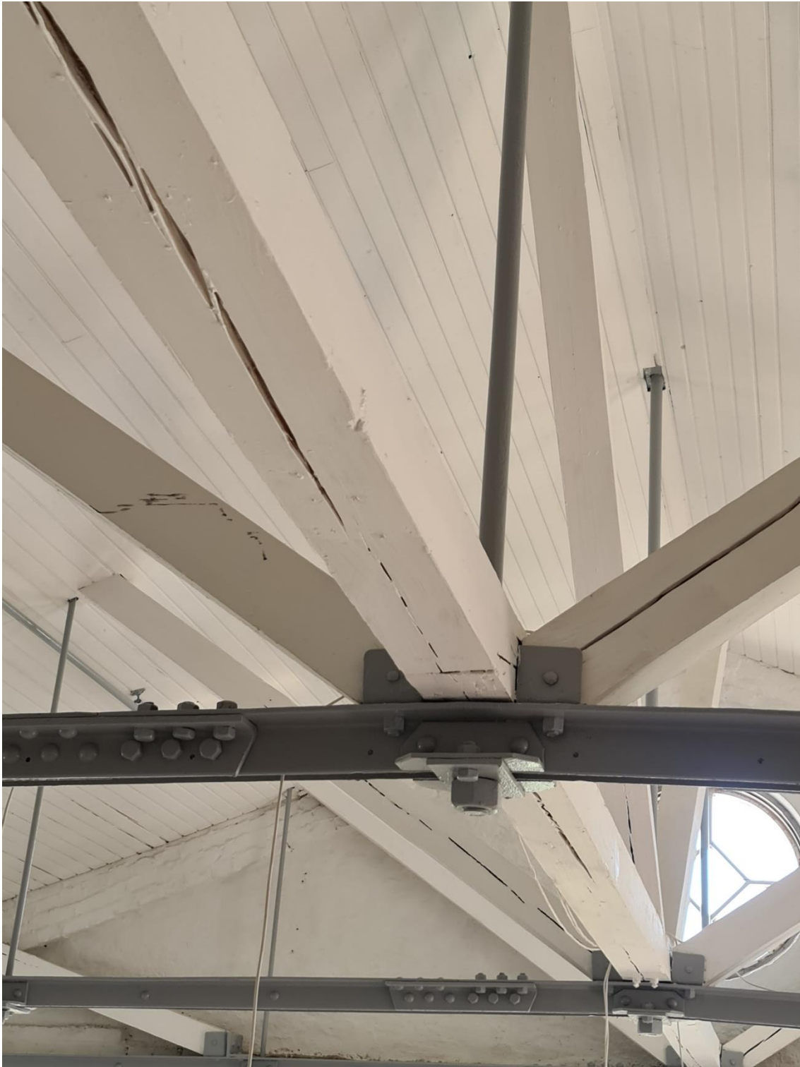
Kuva 28. Kattorakenteen massiivisia kiinnityksiä.
