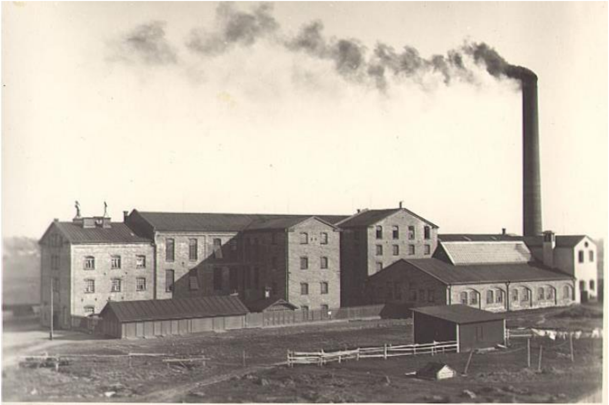
Kuva 24. Kutomon luoteissivu vuonna 1909. F2-osan katolla on vielä paikallaan suuri kattoikkuna. Lisäksi F2-osan seinän holvikaariaukot on muurattu umpeen ja asennettu ikkunat. F5-osan keskikatto purettu ja osa F3 on vielä korottamatta (Snickars, A 1909. Åbo Akademin arkistokokoelma).
