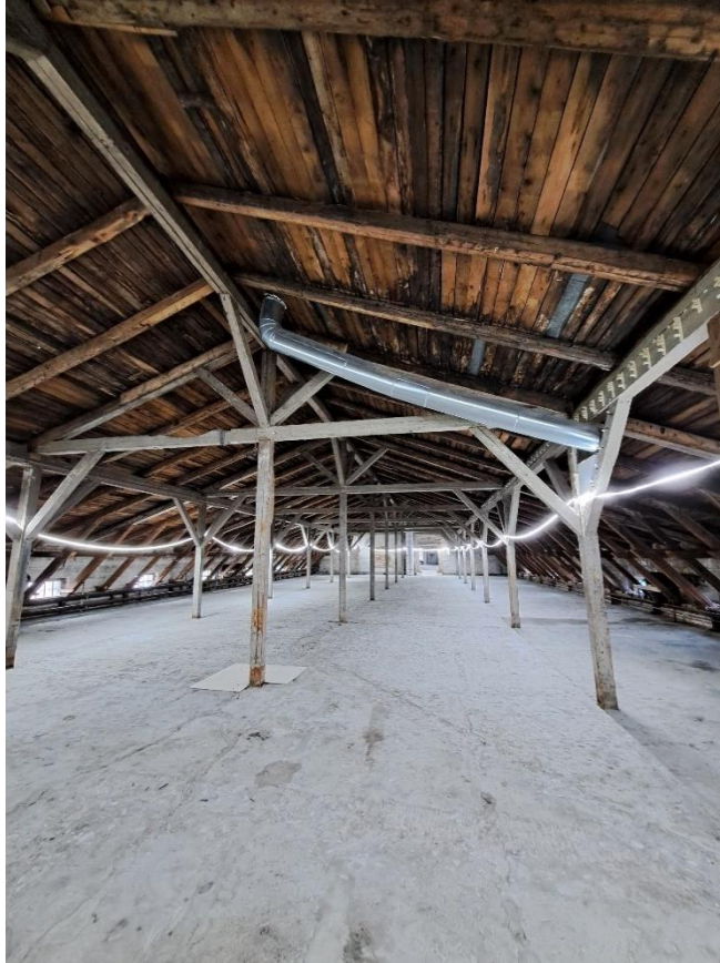
Kuva 30. F3-osan vesikaton rakenteita vuonna 2022.
