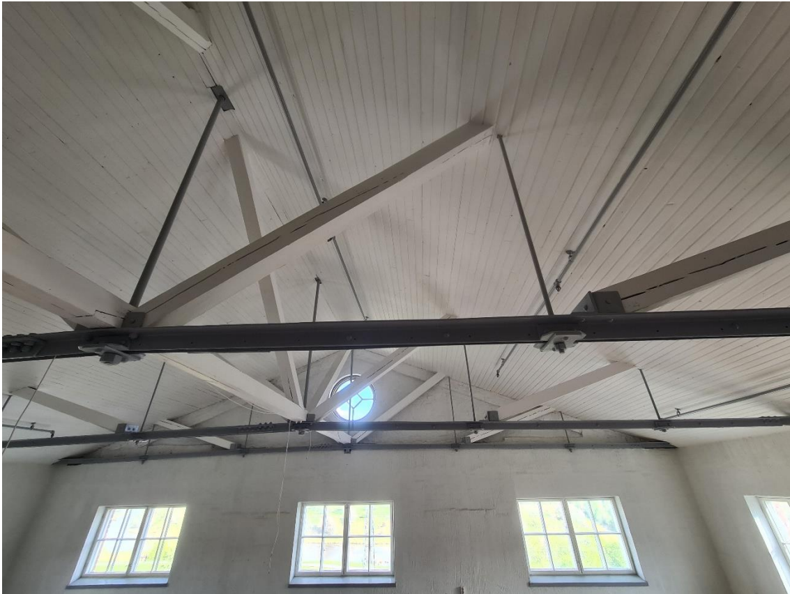
Kuva 29. Osan F6 kattoristikoita.
