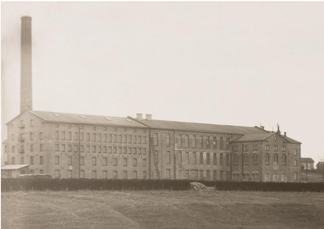
Kuva 50. Julkisivukuva kaakkoon (Turun museokeskus).
