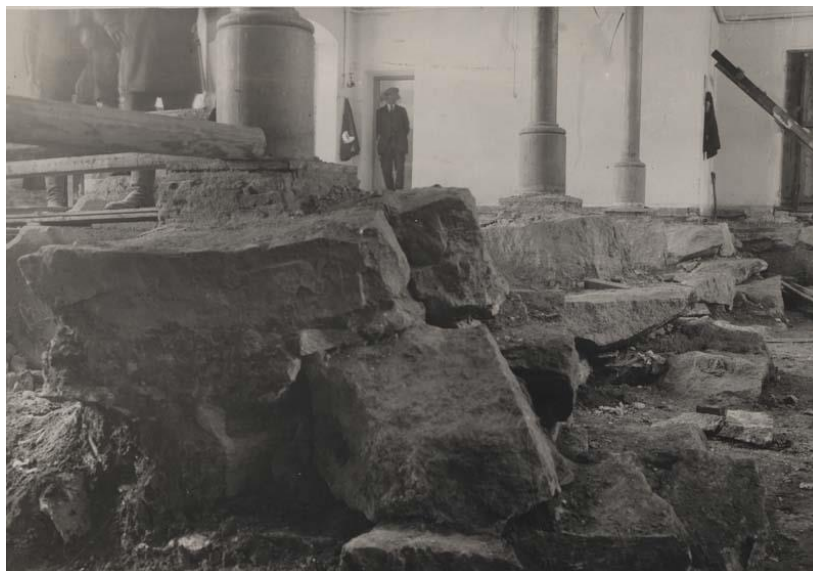
Kuva 25. Perustusten muutos- ja korjaustöitä vuonna 1922 (Gustaf Wellin 1922. Turun museokeskus).
