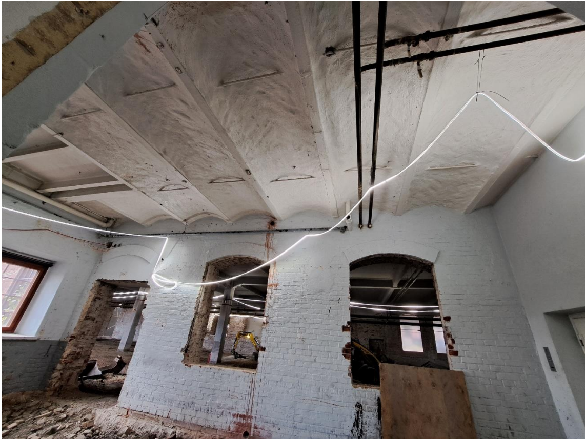
Kuva 43. F6-osan tiilikappaholvin alapinta.
