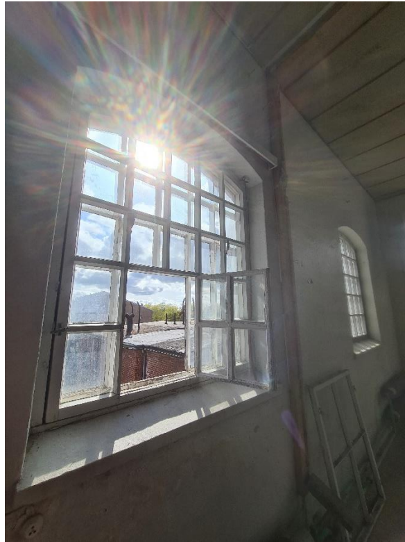
Kuva 47. Ikkuna, jossa avattava tuuletusluukku kuvattuna osan F21 sisältä.
