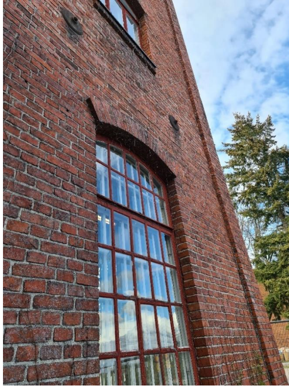
Kuva 46. Osan F8 ikkunaruutu ulkoapäin.
