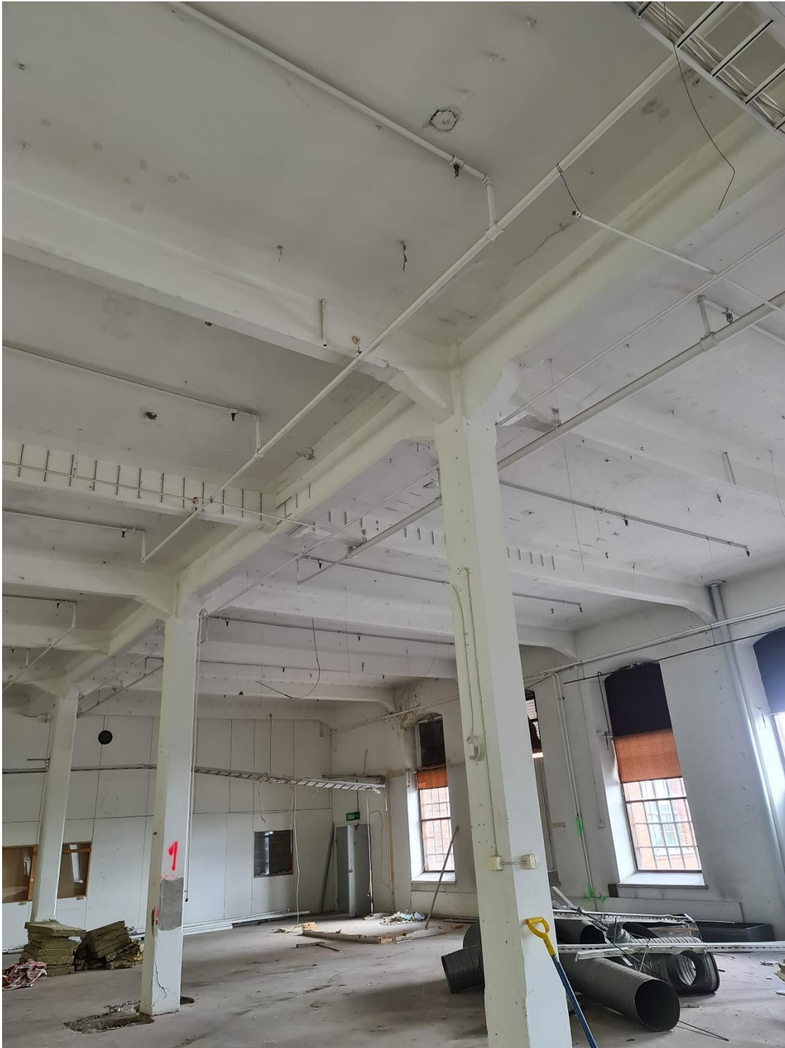
Kuva 39. F4-osan toisen kerroksen holvin kantavia rakenteita.
