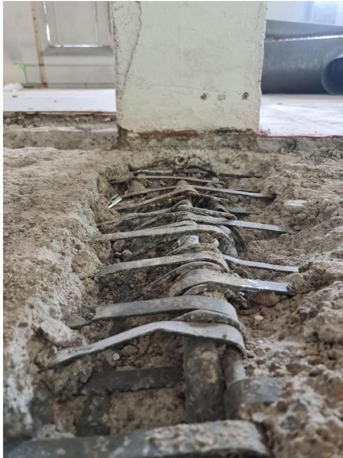
Kuva 40. F4-osan palkin ja pilarin liittymän raudoitusta.
