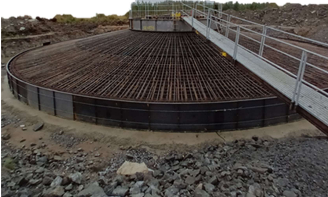
Kuva 4. Paaluperustus ennen valua
