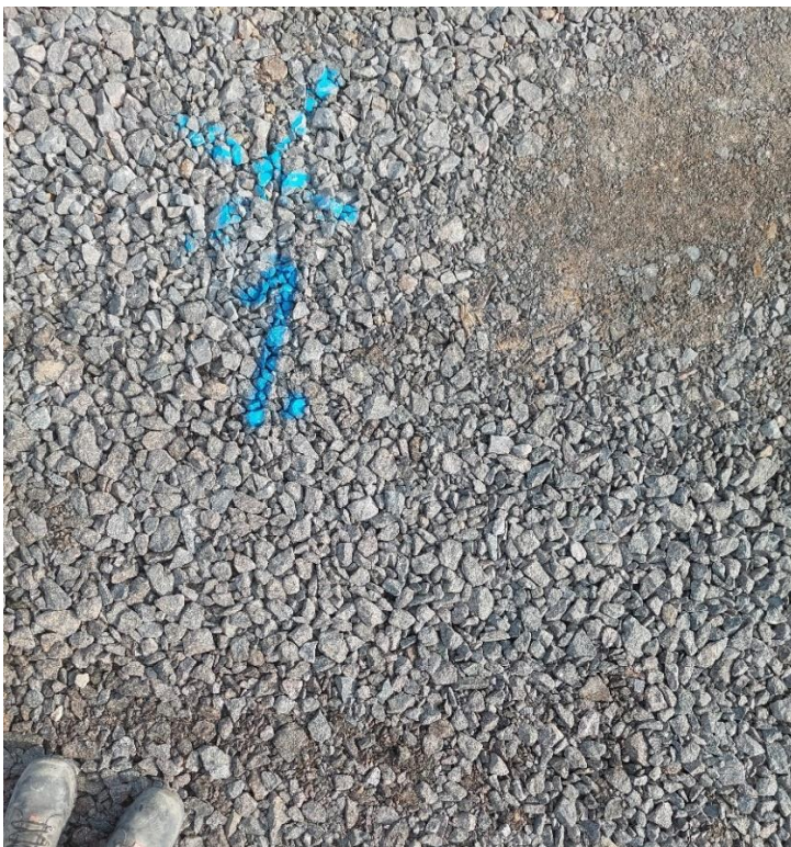
Kuva 8. Jakavan kerroksen pinta paalulla 722
