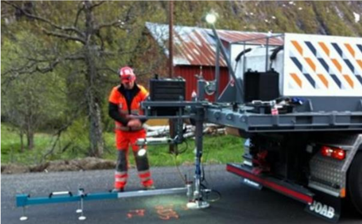
Kuva 6. Kuorma-auton perässä oleva levykuormituslaite (Statens vegvesen 2021, 205)
