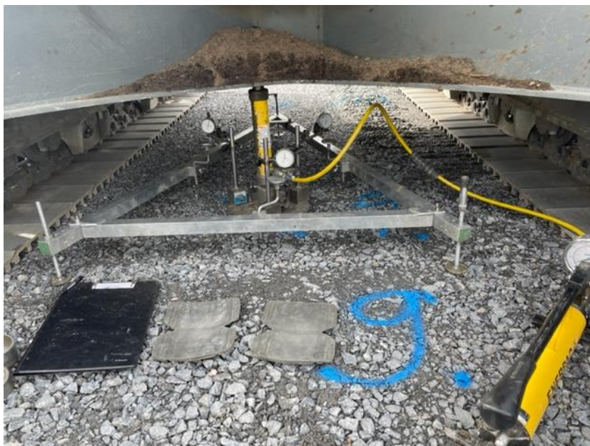
Kuva 4. Valmiiksi asennettu levykuormituslaite tutkimuspisteellä 9
