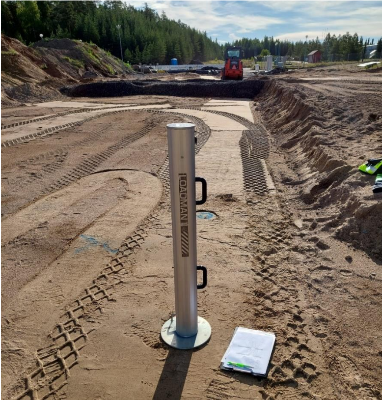
Kuva 7. Tärylevyllä (vasemmalla) ja valssijyrällä (oikealla) tiivistetty pohjamaa
