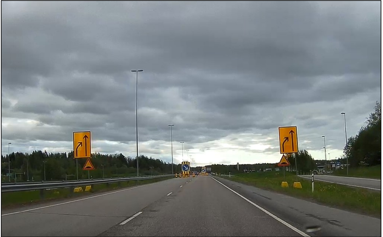
Kuva 12. Valtatiellä 6 opastusmerkkien pystytys betoniporsailta ja varoitusmerkit töyssystä opastusmerkkien yhteydessä
