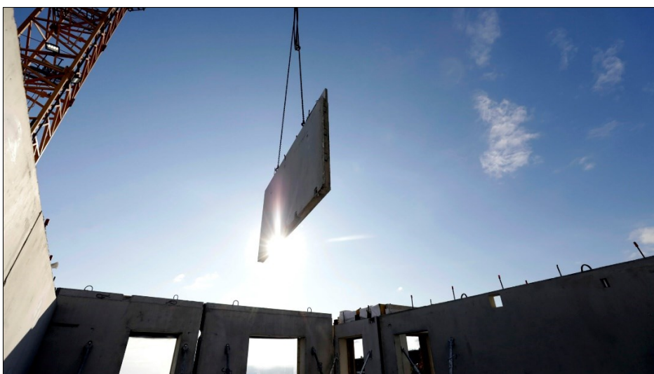
Kuva 8. Betonisen elementtiseinän paikalleen nostaminen (Takala 2021)
