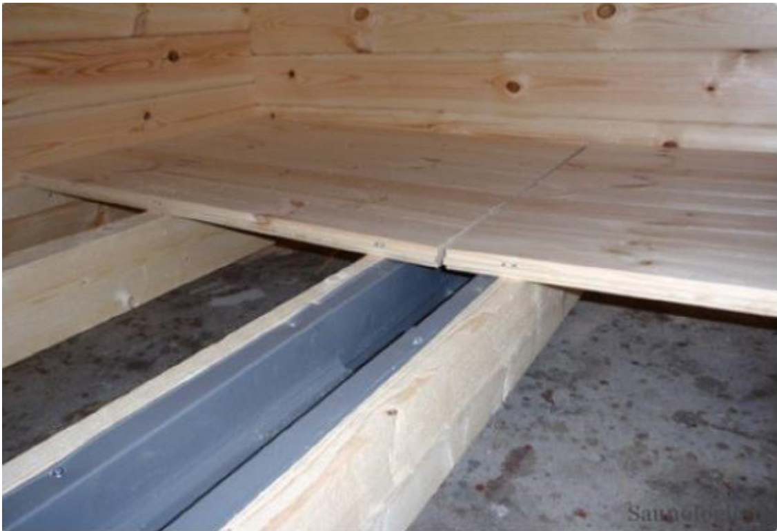
KUVA 4. Vesikourun esimerkkiasennus, Masterhouse. (17)
