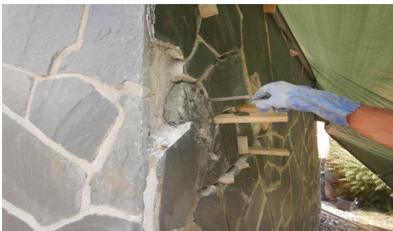
Kuva 11. Tukikiilojen avulla kivet saadaan asennettua oikeaan kohtaan
