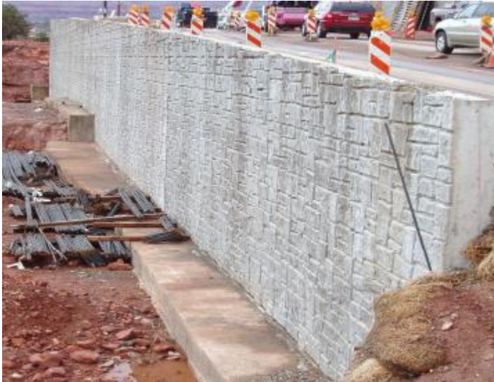
Kuva 6. Teräsbetoninen kulmatukimuuri on rakennettu anturan päälle. (Niko Le- hikoinen)
