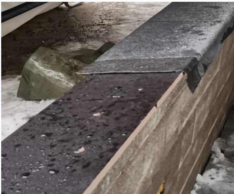
Kuva 13. Kuvassa olevaan muuriin tehty kallistus viistetyllä puulla ja vesivaanerilla
