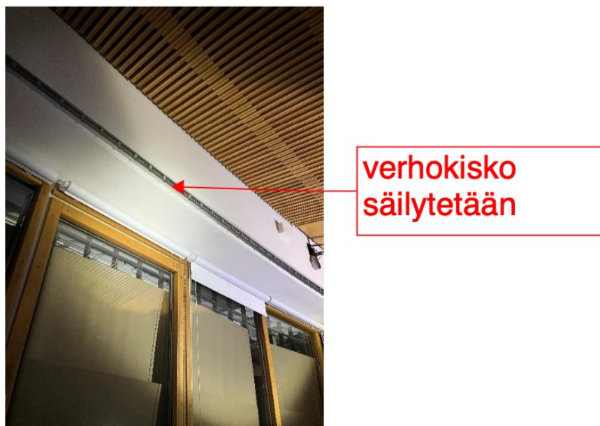
Kuva 9. Ote purkuun menevän lohkon ennakkokatselmus pöytäkirjasta. Katselmuksessa tarkennettu suunnitelmista puuttuvaa tietoa.
