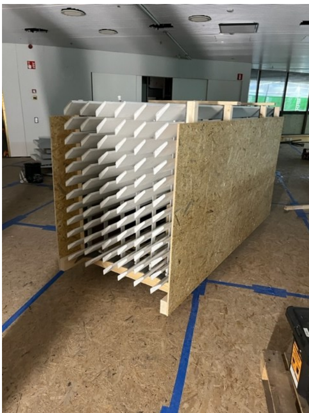
Kuva 3. Talteen otettuja sisäpuolen ikkunasäleiköitä.
