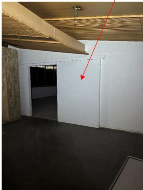
Kuva 11. Ote purkuun menevän lohkon ennakkokatselmus pöytäkirjasta. Katselmuksessa tarkennettu suunnitelmista puuttuvaa tietoa.
