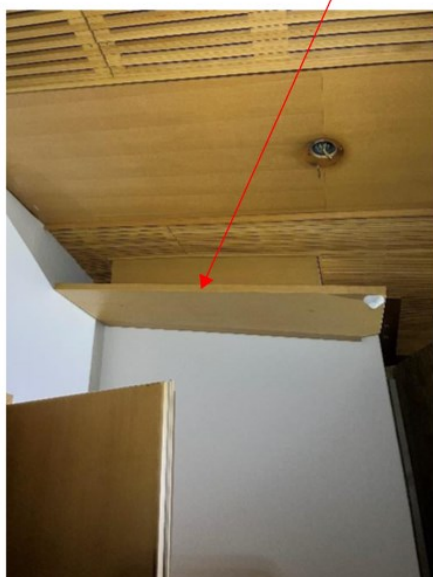
Kuva 12. Ote purkuun menevän lohkon ennakkokatselmus pöytäkirjasta. Katselmuksessa tarkennettu suunnitelmista puuttuvaa tietoa.
