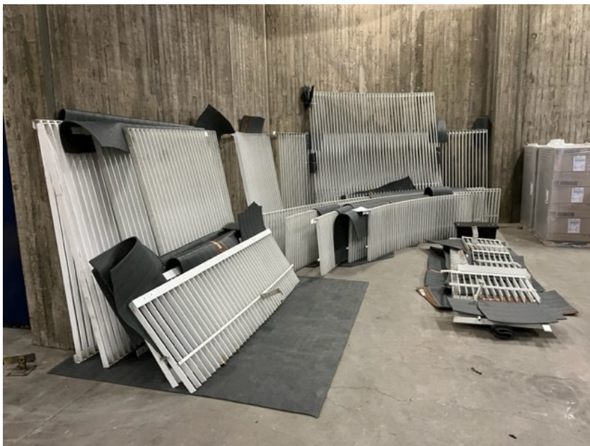
Kuva 5. Rakennuksen ulkopuolelta talteen otettuja ikkunoiden metallisäleikköjä varastoituna.
