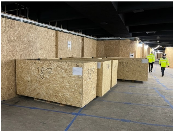
Kuva 4. Talteen otettuja alakattoelementtejä siirtymässä varastoon.
