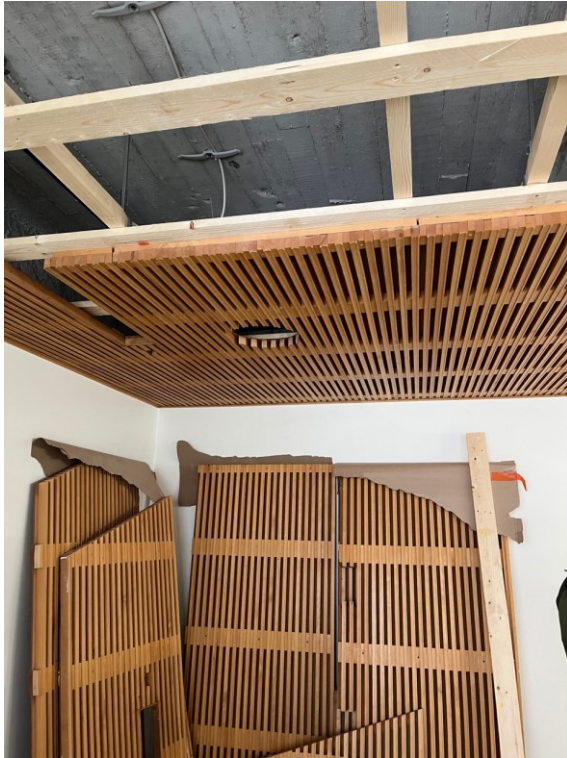
Kuva 24. Talteen otettujen alakattoelementtien koeasennus käynnissä.
