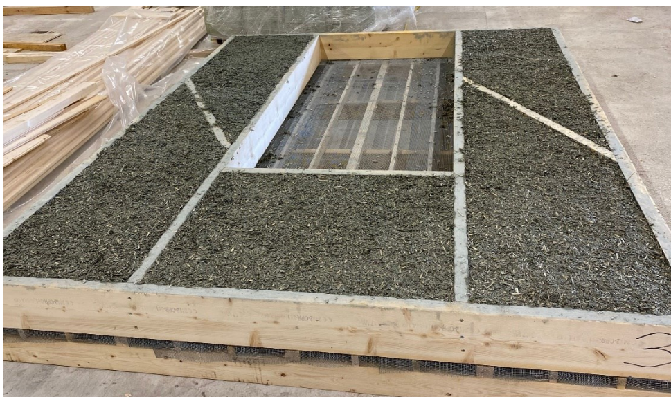
Kuvio 1. 20 cm paksu seinäelementti kuivausalustan päällä. (Päätaalo Oy 2023.)
