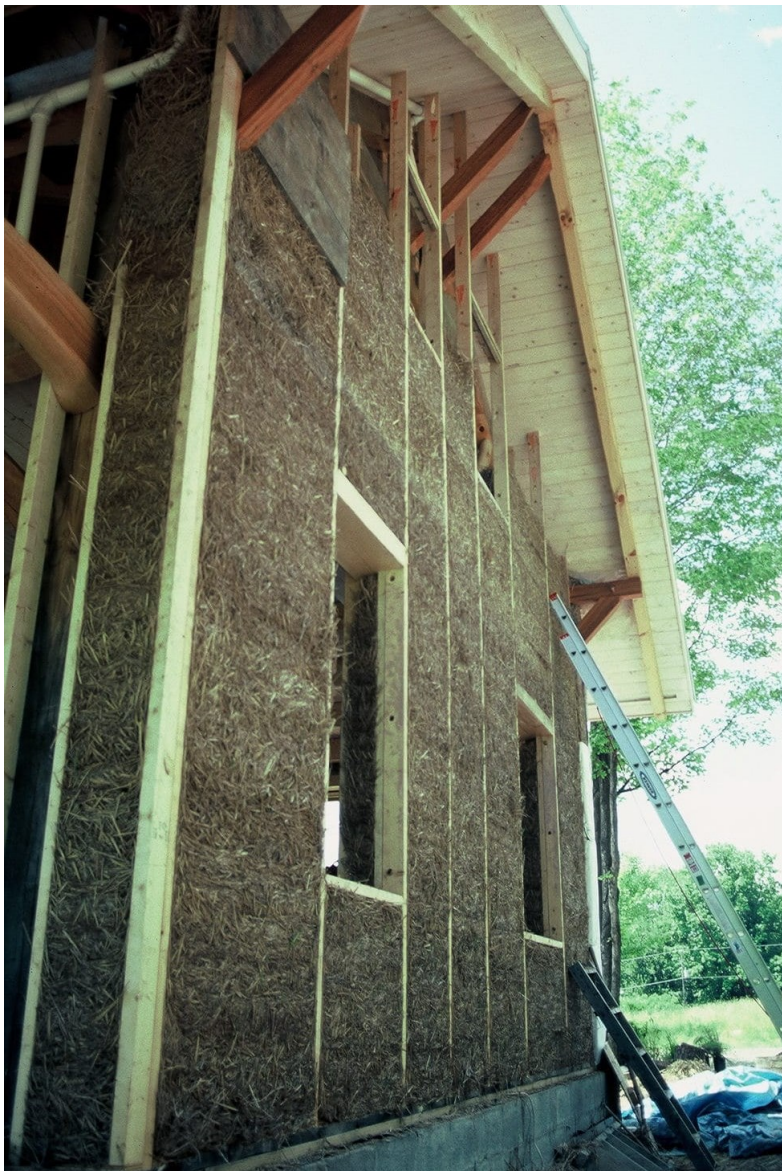
Kuvio 2. Kevytsavella liukuvalettu seinärakenne. (Timberhomes 2023.)
