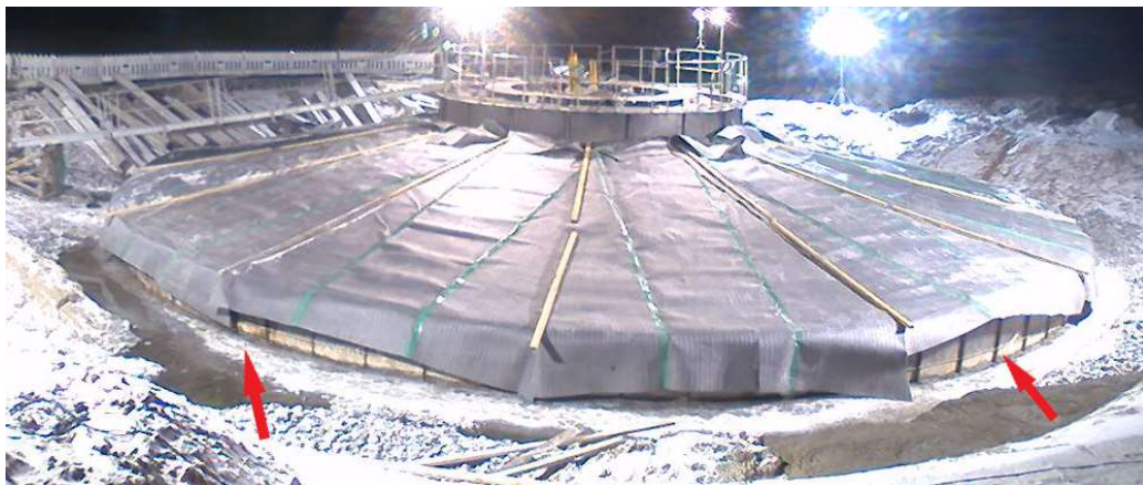
Kuva 16. Peitetyn perustuksen lämmöneristyksen parannuskohteet
