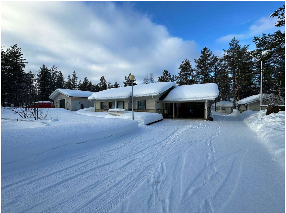
Kuvio. 2 Esimerkkikohteen julkisivu
