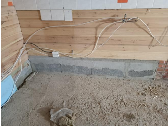
KUVA 10. Keittiön ja saunan välinen seinä
