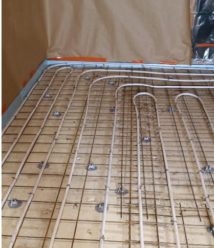
KUVA 12. Lattialämmitysputket asennettu verkkoon
