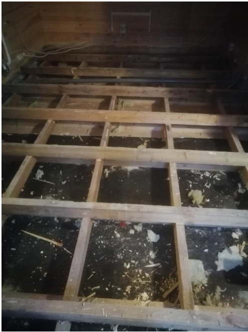
KUVA 8. Vanhan lattian rakenne
