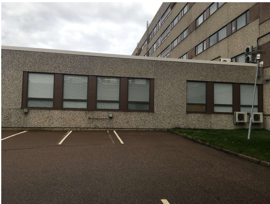
Kuva 10 Huoneen BK0128 ikkunat
