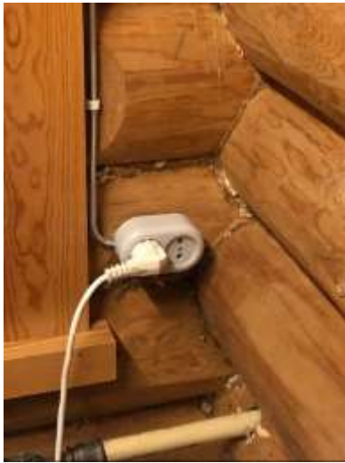
Kuva 30. Höyterin sisäpuolista hirsiseinää.
