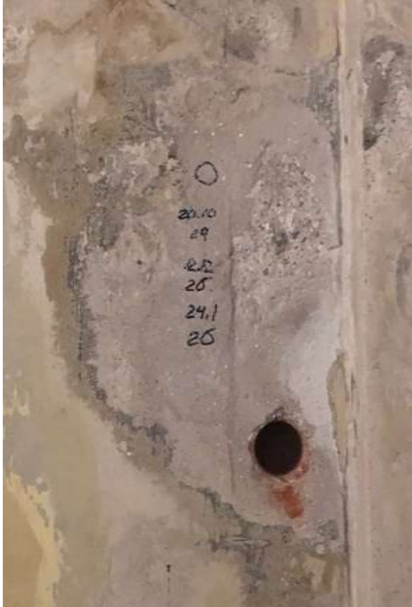
Kuva 12. Sisäseinien kuivumista seurataan kosteusmittauksin.
