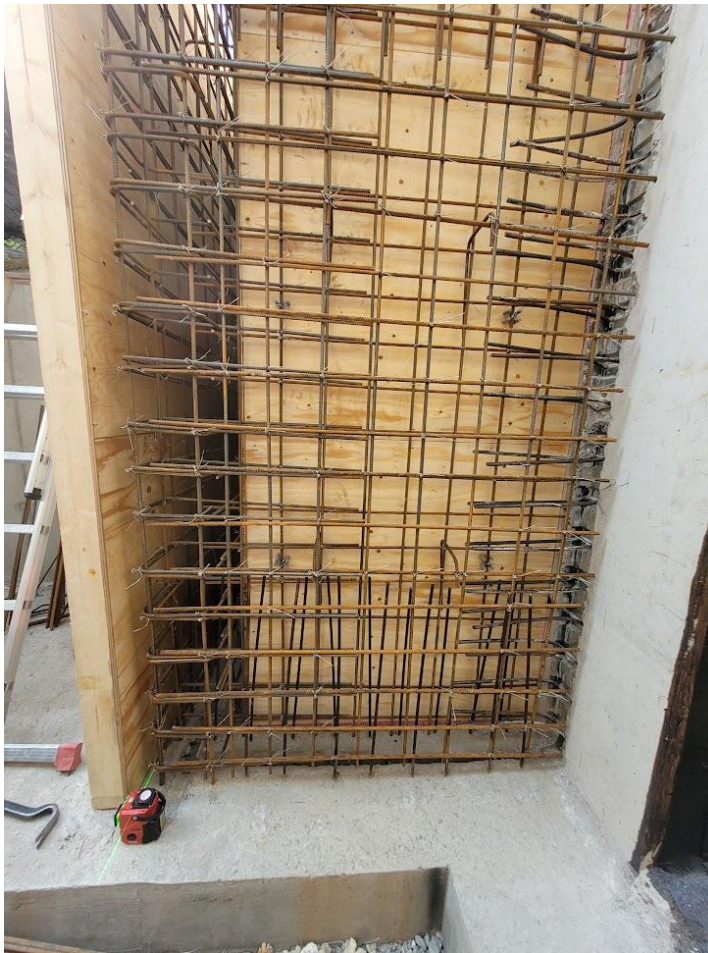
KUVA 5 Vanerista tehty seinämuotti.
