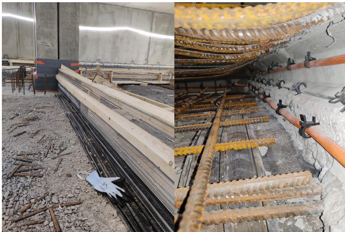
Kuva 6. Parkkihallin lattialaatan vesitiivis työsauma eri työvaiheissa.
