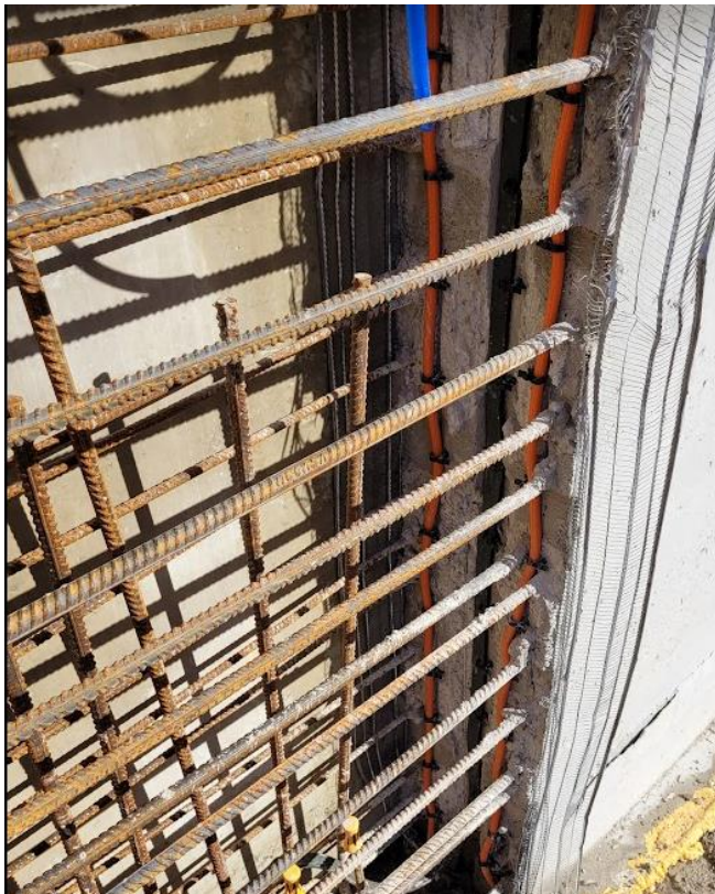
KUVA 8. Injektointiletkupari asennettuna seinän työsaumassa.
