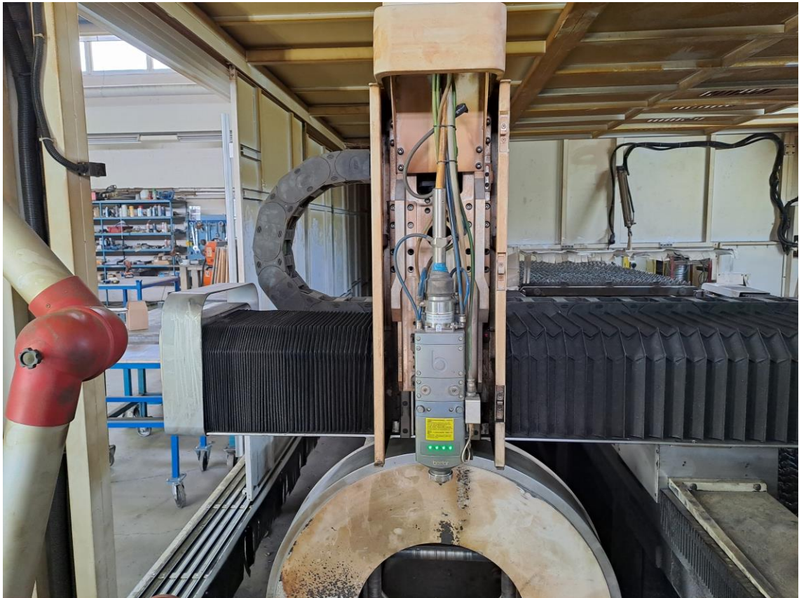
Kuva 3. Laserin leikkuupää putkipuolen etupakan edessä, Riku Kokko
