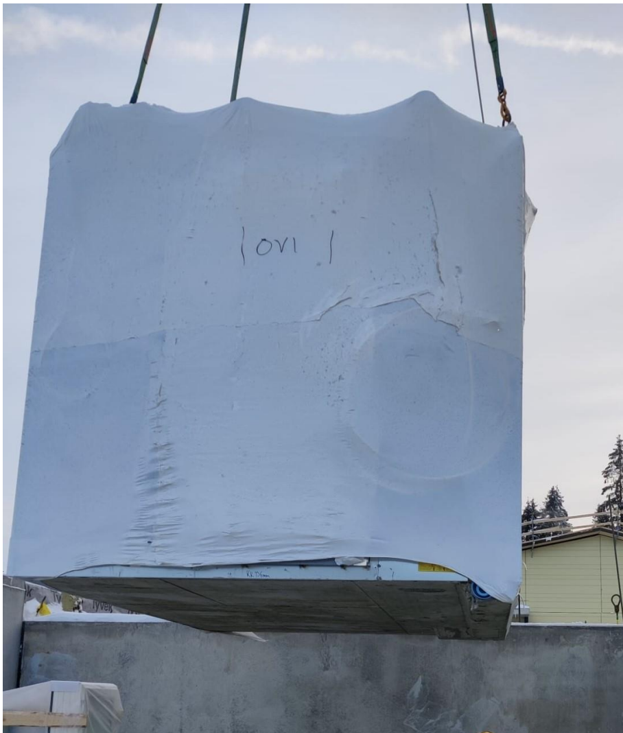
KUVA 2. Muovilla suojattu kylpyhuone-elementti nostetaan nostoraksien avulla suoraan kuormasta. Kylpyhuoneen pohjassa näkyvälle viemäriveraukselle on varattava tilaa kylpyhuoneen syvennyksessä. (Arkta Rakennus Oy. Ilokkaanrinne 5–6)
