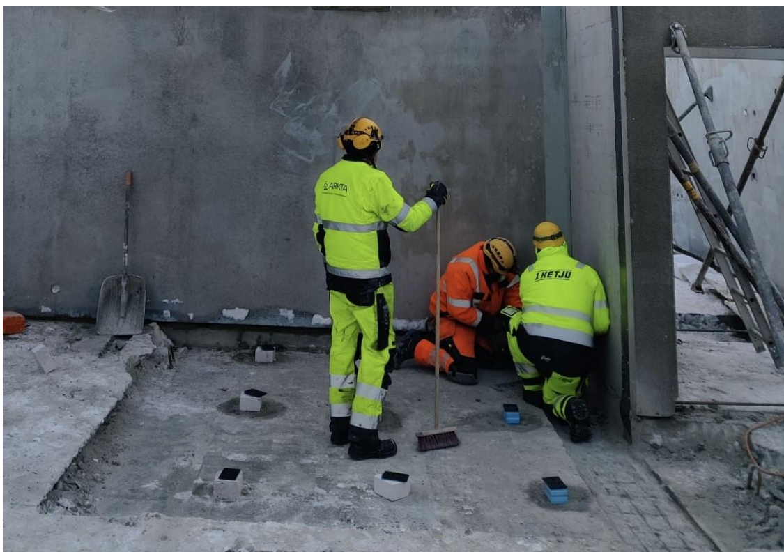
KUVA 1. Kylpyhuonesyvennyksen asennuspalat valmiina kylpyhuone-elementin asennusta varten. (Arkta Rakennus Oy. Ilokkaanrinne 5–6)
