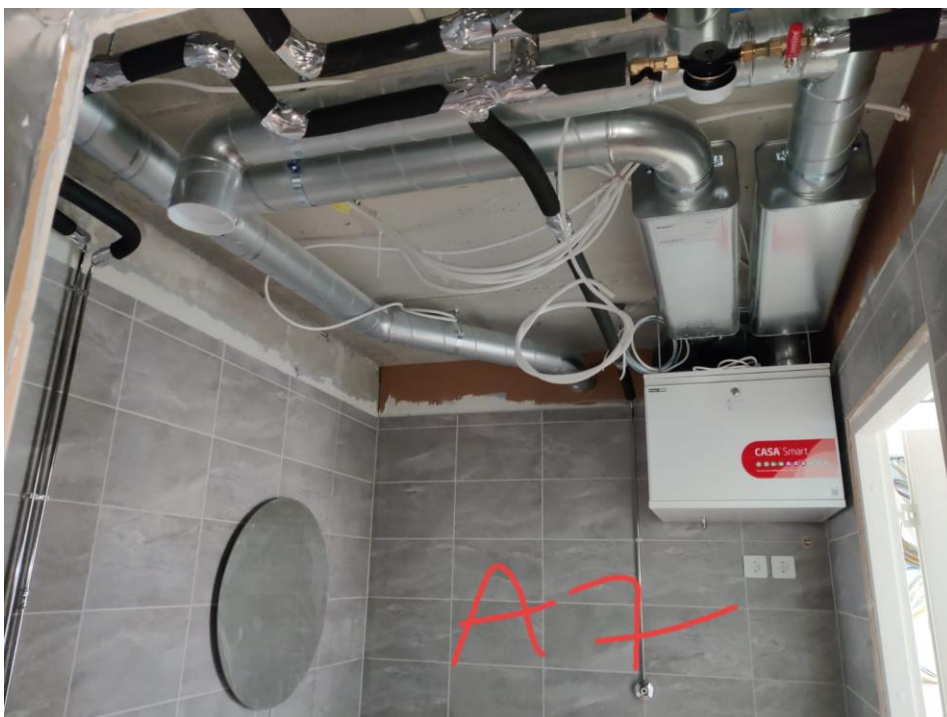
KUVA 6. Kylpyhuone on laatoitettu ja vesikalustusta varten on asennettu pintakromiputket. Katon vesiputket on eristetty, seinän pistorasiat asennettu ja IV-laite kytketty. (Arkta Rakennus Oy. Tampereen Auringonkukka)
