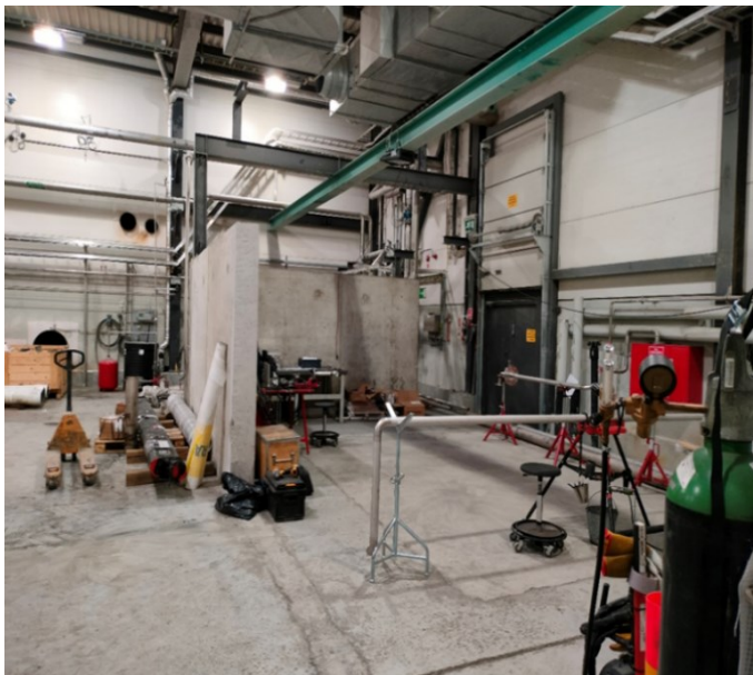
Kuva 16. Vanhan happilaitoksen tulityöpaikka
