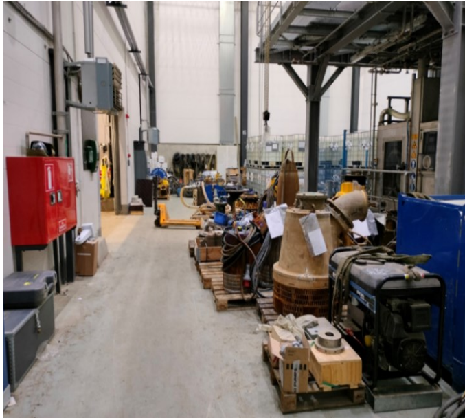
Kuva 11. Pumppuhuollon tila, pakkaamo
