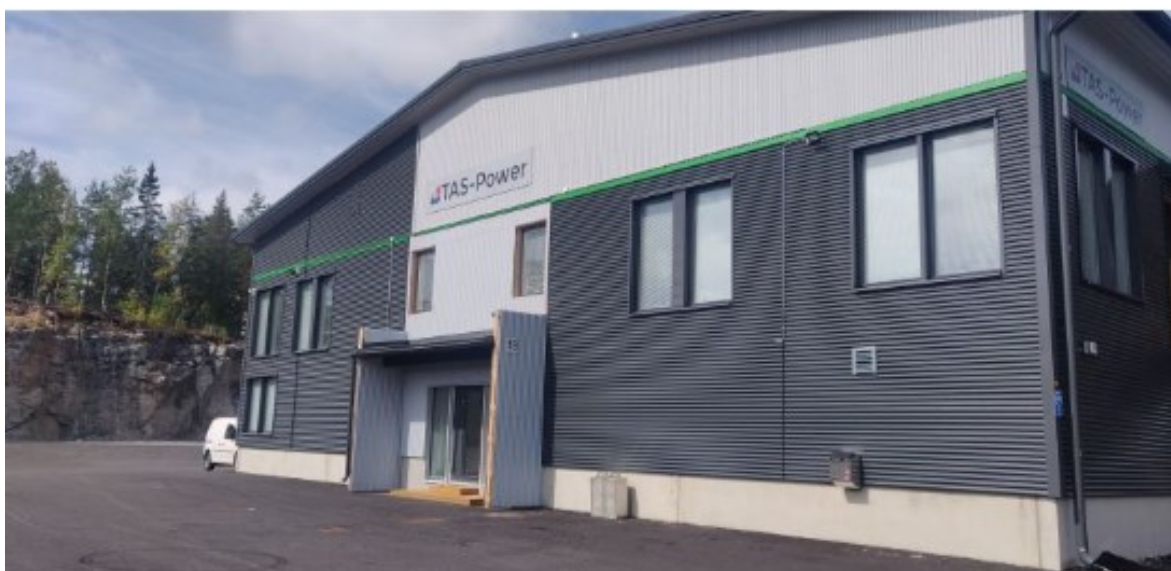
Kuva 2. TAS – Power Oy toimitilat (Lundqvist 2022)
