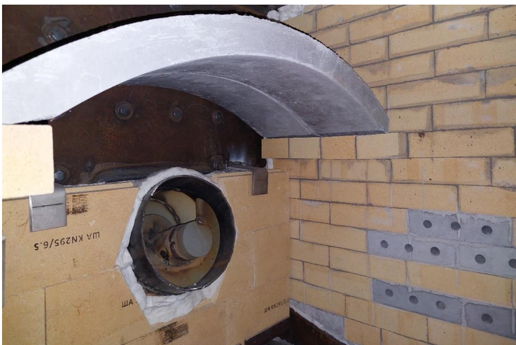
Kuva 5. Holvikaaret ja muuraukset.
