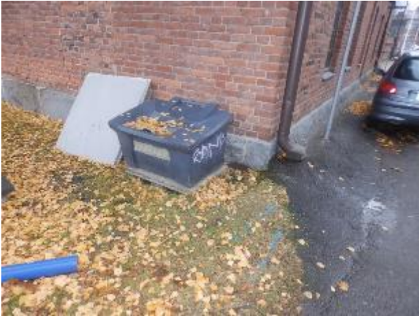
Kuva 62: Osittain sadevedet on johdettu kadulle. asfaltoidun pihan kallistus on rakennuksesta poispäin. Pihaliittymän puoleisessa päädyssä nurmikko kivijalkaa vasten.
