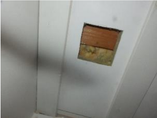
Kuva 82: Otettiin materiaalinäyte tarkkaamon akustolevyillä tehdyn alakaton yläpuolella olevasta villaeristeestä.
