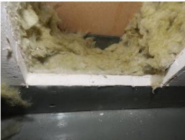
Kuva 37: Iv-laitetila, väliseinässä teräsranka ja kivivillaeristys. Eristeessä ei havaittu aistinvaraisesti poikkeavaa hajua tai muita vaurioita.
