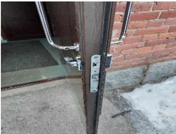
Kuva 23: Ulko-ovet teräs/ peltikuorella. Ei havaittu lukkojen toimivuudessa ongelmia.
