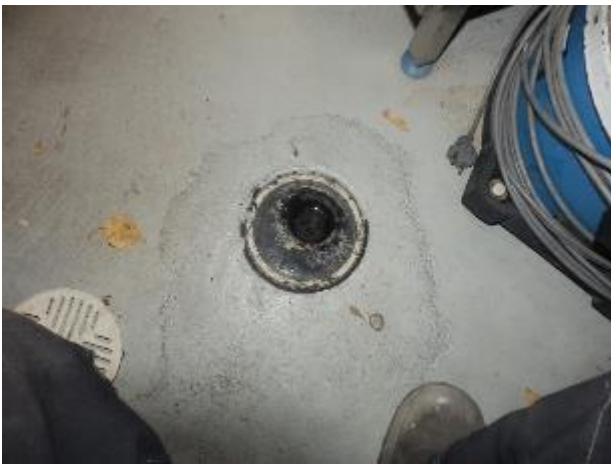
Kuva 89: Tarkastettiin lattiakaivot silmämääräisesti, lattiakaivoissa ei havaittu aistinvaraisesti vaurioita.
