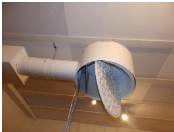
Kuva 79: Tuloilman pölynkoostumusnäytteet otettiin tulokanavasta päätelaitteen takaa.
