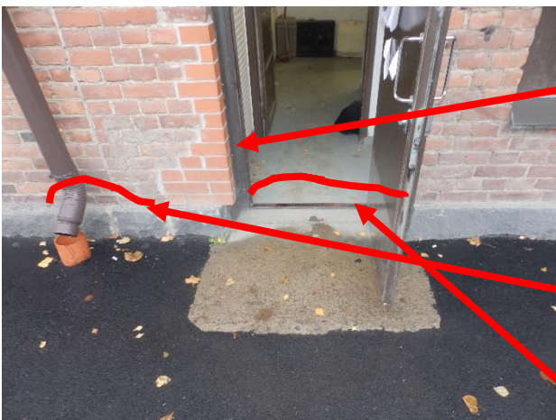
Hannes Kolehmainen kadun puoleinen sisäänkäynti
