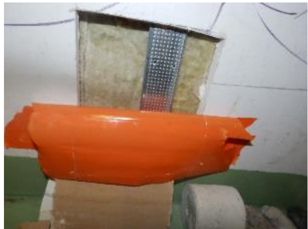
Kuva 85: Otettiin materiaalinäyte bänditila 7 väliseinän villaeristeestä.
