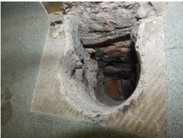
Kuva 7: Kantavan väliseinän viereen tehty rakenneavaus alapohjaan tilassa 002 bänditila. Lattiassa on muovimatto. Lattiavalun ja tiiliseinän liitos ei ole silmämääräisesti tarkasteltuna tiivis, mutta on tiivistetty muovimatolla. Pohjalla tiiltä osana perustusta.
