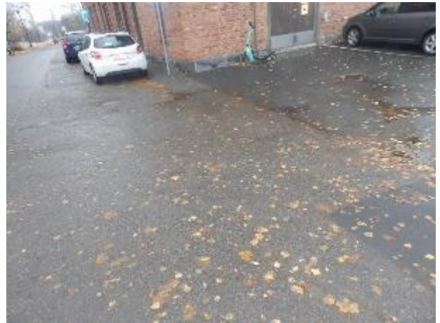
Kuva 65: Pihan kallistus on poispäin rakennuksesta. Piha on talon ympäriltä pääosin asfaltoitu.
