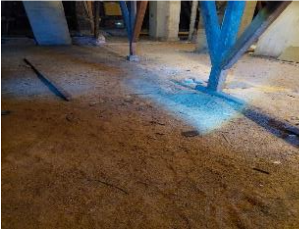
Kuva 53: Yläpohjan puurakenteet ovat eristepinnan yläpuolella nostettu kivirakenteella, ei havaittu vesikaton kantavissa rakenteissa vaurioita.
