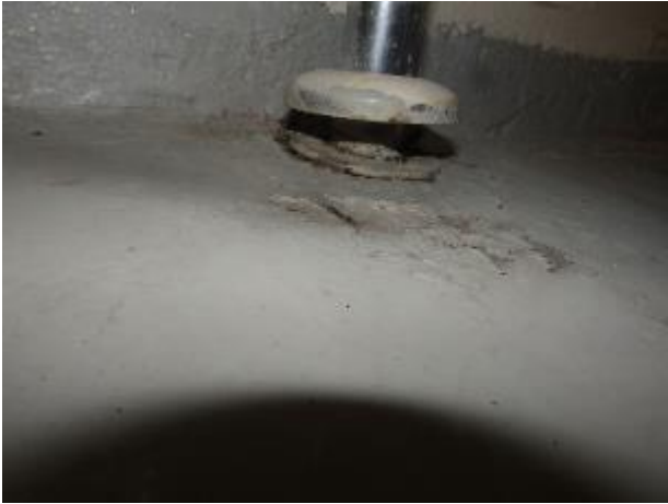
Kuva 91: Tarkastettiin viemärien liitoksia merkisavun avulla, ei havaittu ilmavirtauksia viemäriinliitoksista.
