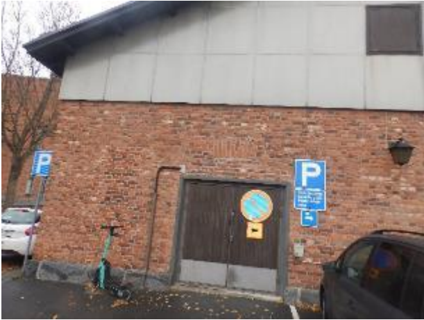
Kuva 25: Toisessa päädyssä on puiset pariovet, ei havaittu toimivuudessa puutteita.
