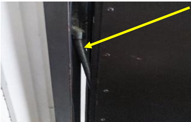
Kuva 27: Ulko-ovessa ei ole ovipumppua vaan jousi oven pielessä. Ei havaittu ovien mekanismin toimivuudessa puutteita.
