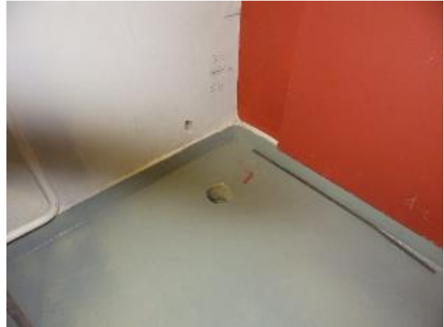
Kuva 14: Ulkoseinän rakenne varmistettiin poraamalla seinään reikä ikkunan syvyyteen, ei havaittu muita rakennekerroksia. Ulkoseinät ovat massiivitiiliseiniä ennakoarvion ja arkkitehtikuvan mukaisesti.
