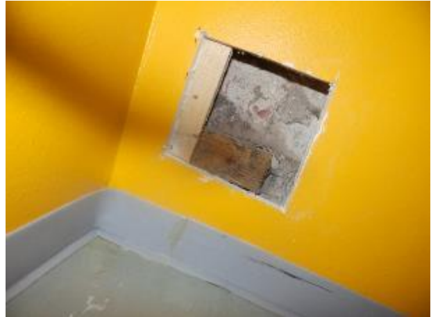
Kuva 83: Otettiin materiaalinäyte tarkkaamon ulkoseinässä olevasta puukoolauksesta, levytetyn seinän sisällä ei eristeitä rakenneavauskohdalla.
