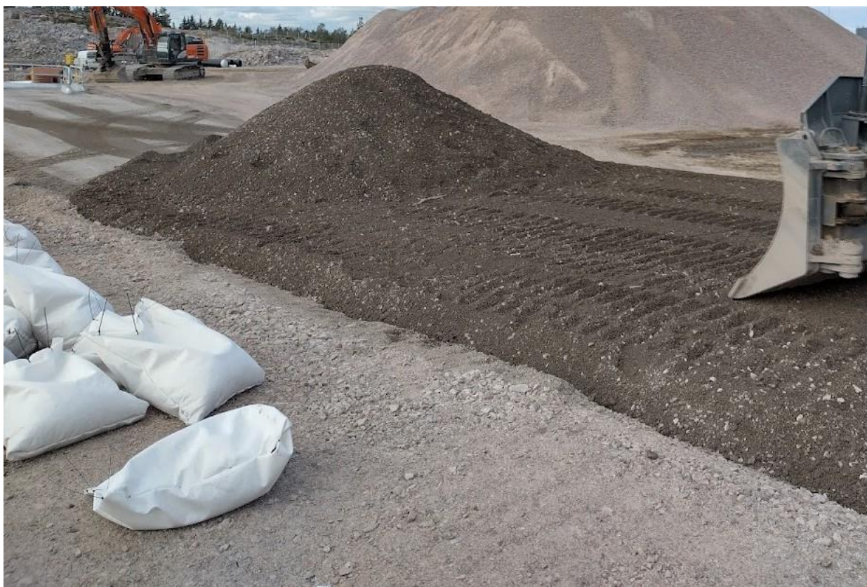
Kuva 1. Yhdyskuntajätteenpolton pohjakuonaa levitetään kenttärakenteeseen. Kuvan vasemmassa laidassa rakenteeseen sijoitettavia hienonemissäkkejä (Ahlqvist 2021)
