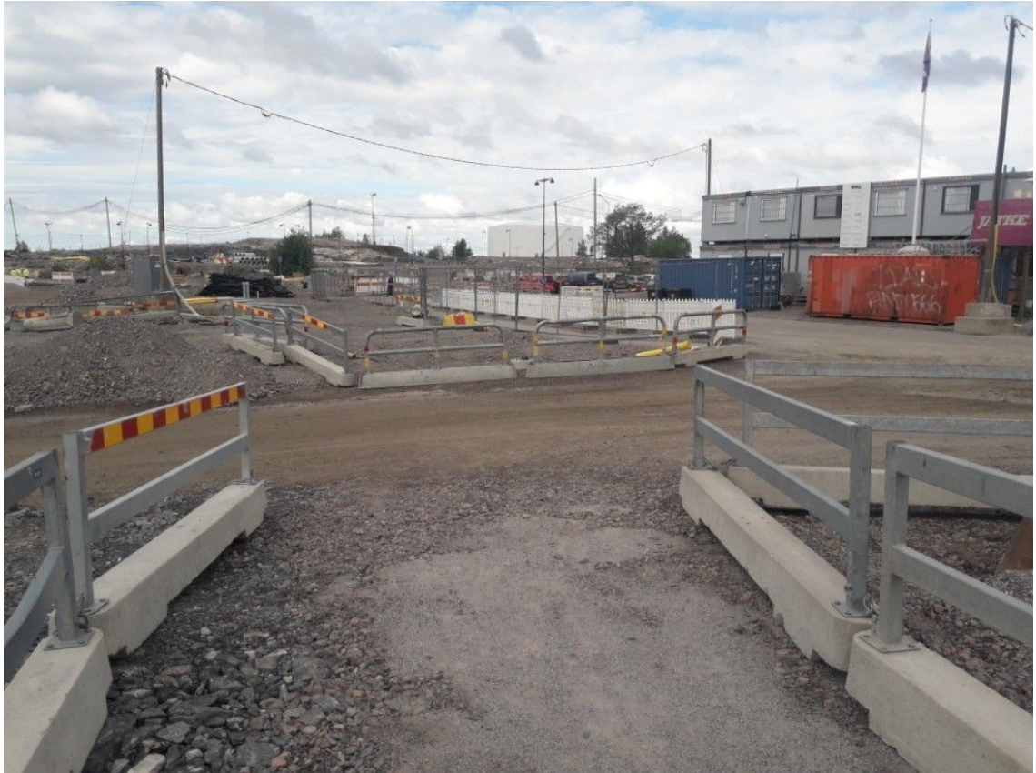
Kuva 12: Virrehavainto, Kruunusillat -allianssin Haakoninlahden työmaa-alueen liikennejärjestelyt.
