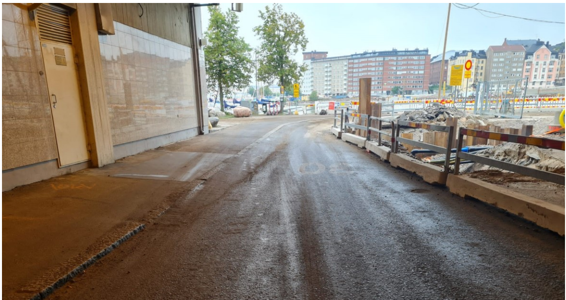
Kuva 1: Kruunusillat -allianssi, liikennejärjestelyt Haapaniemenkadun tunnelin eteläpäässä.
