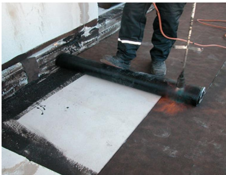
Kuva 24. Parvekkeen vedeneristys bitumilla. ( www.rakentaja.fi/tv/e766parvekkeen_vedeneristys.aspx )
