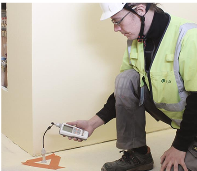
Kuva 31. Porareikämittaustulosten perusteella voidaan betonille antaa hyväksyttävä päällystyslupa. (Betonin kosteuden mittaus porareikämittauksella, www.Vertia.fi )
