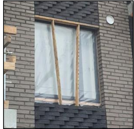
Kuva 36 Aukkotuennat asennettuna, JM Suomi Oy
