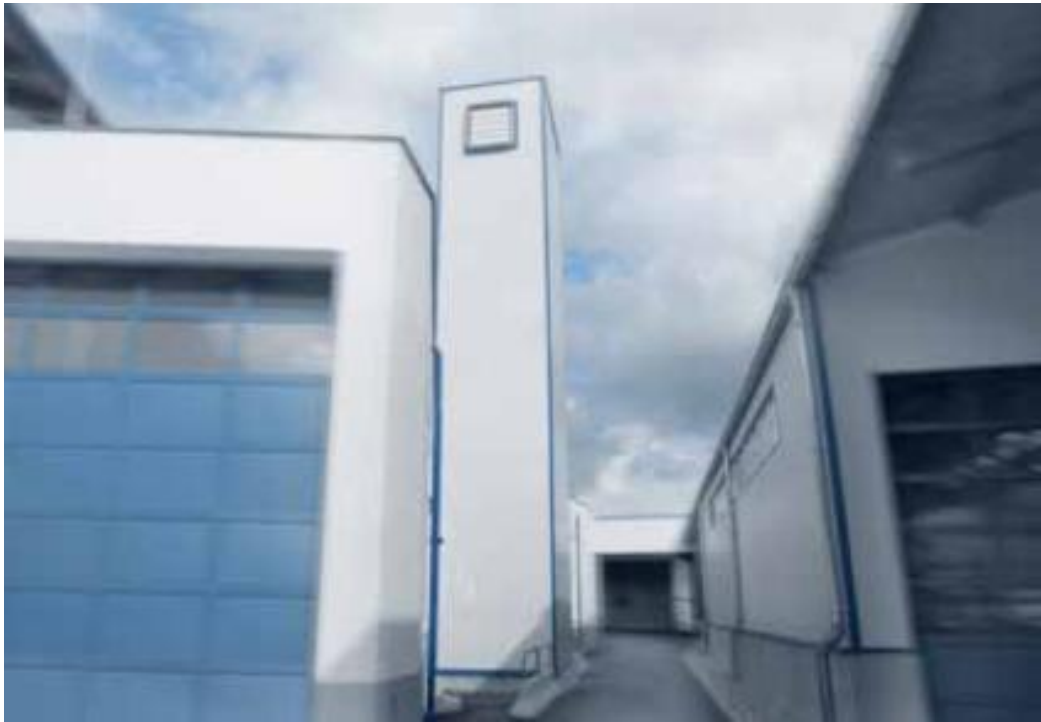
Kuva 12. Logimat sijoitettu ulkoseinään.
