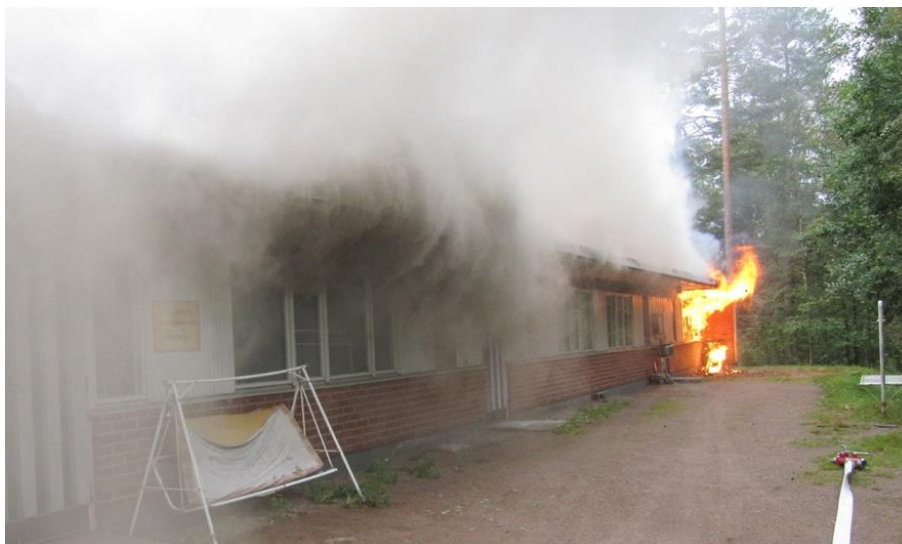
KUVA 1. Rivitalon huoneistopalo Kotkassa 3.9.2009, jossa purkautumisvaiheessa oleva palo on jo levinnyt yläontelotilaan (Kymenlaakson pelastuslaitos 2009, CC BY-NC-SA)
