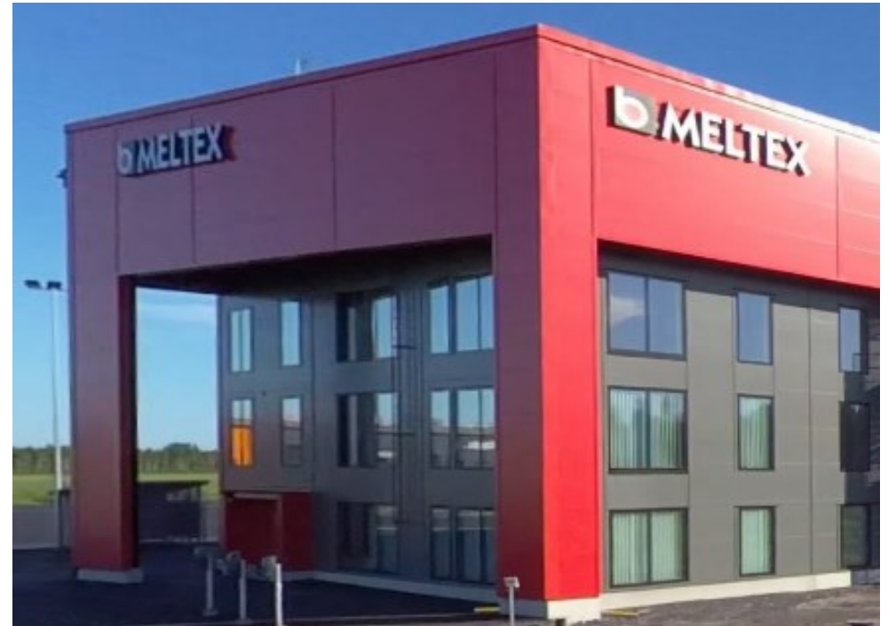
Kuva 13. Linnunrata 26, 90440 Kempele, 19.4.2023. Kohde 3. kerroksessa
