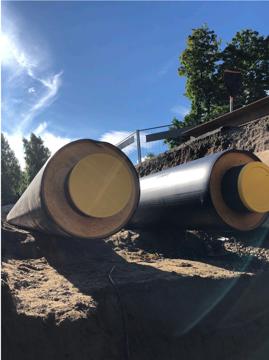
KUVA 3. Kaukolämpöjohtojen rakennusvaihe 2Mpuk. (Kuva: Jalmari Tähtinen 2022)
