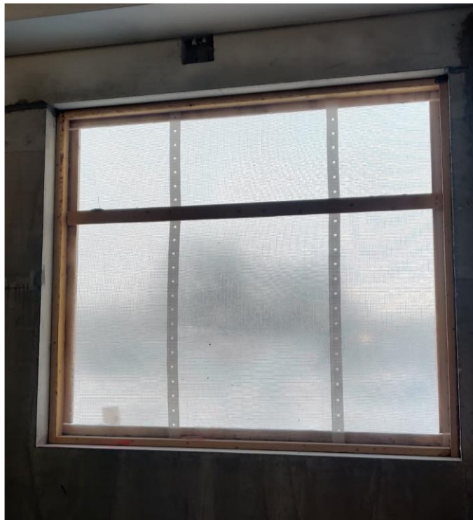
Kuva 4. Aukkosuojaus työmaalla. (Strandberg, 2023)
