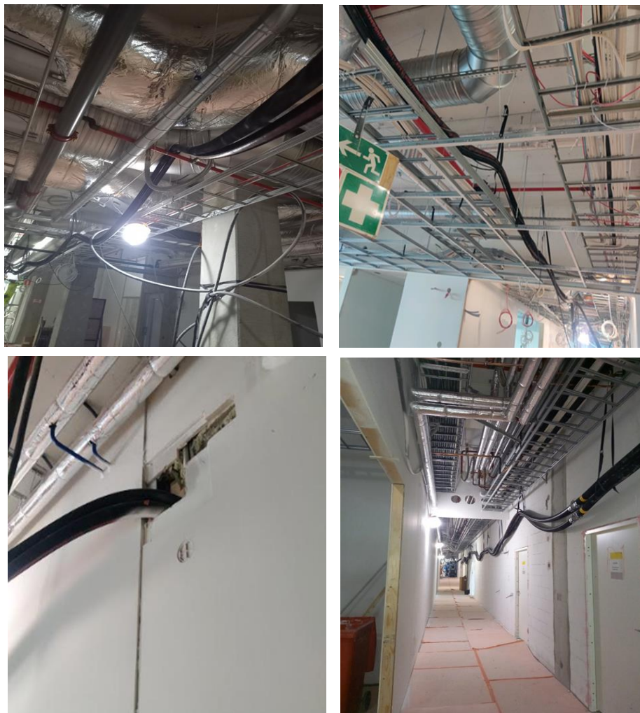
Kuva 15. Lämpöletkuista havaintoja työmaalta. (Strandberg 2023)
