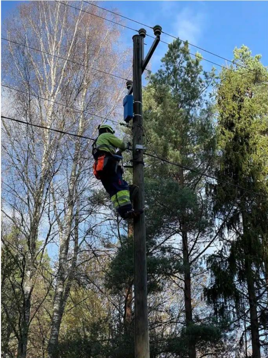
Kuva 11. Safe Gridin Grayhawk-indikaattorin anturin asennus pylvääseen.
