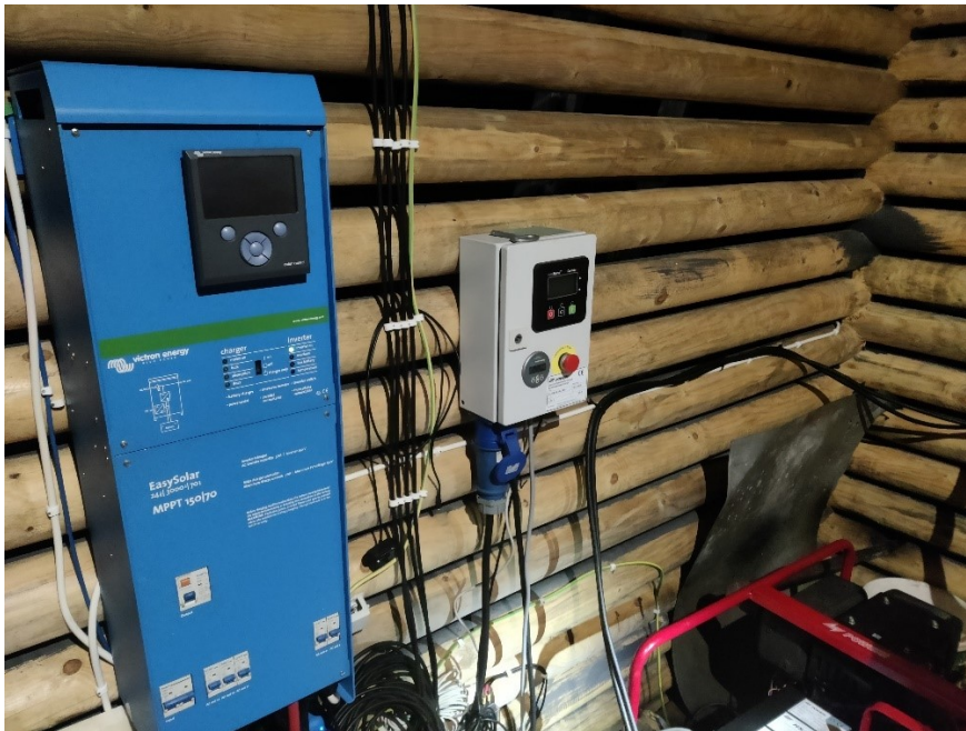
KUVA 1. Victron Energy EasySolar 12/1600/70 -yhdistelmälaite
