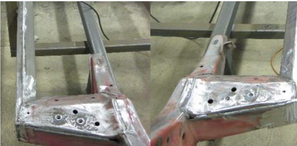
Kuva 40. Etupään runkokotelot korjattuna (Kuvat: Olli Panhelainen).
