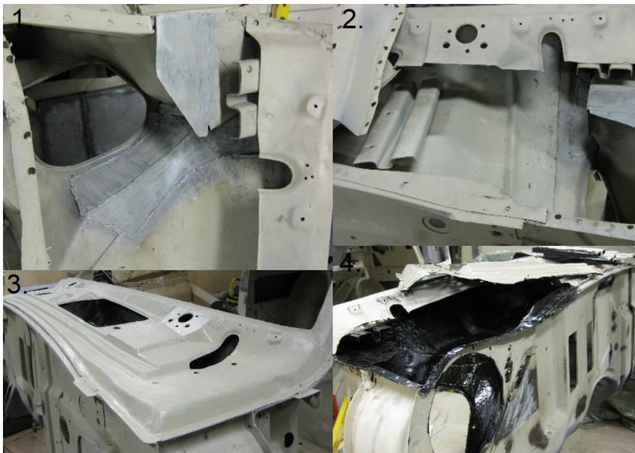
Kuvakollaasi 58. Vesikourun korjaus (Kuvat: Olli Panhelainen).
