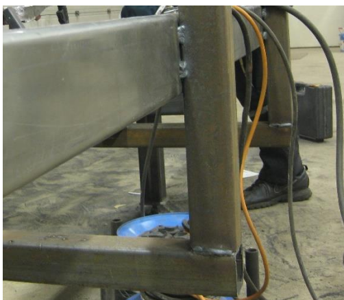
Kuva 38. Uusien palkkien asemointi (Kuva: Olli Panhelainen).
