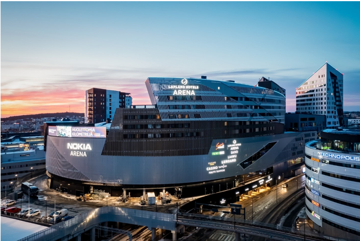
Kuva 1. Nokia Arenan ja Lapland Hotels Arenan julkisivu. (Arco s.a.)
