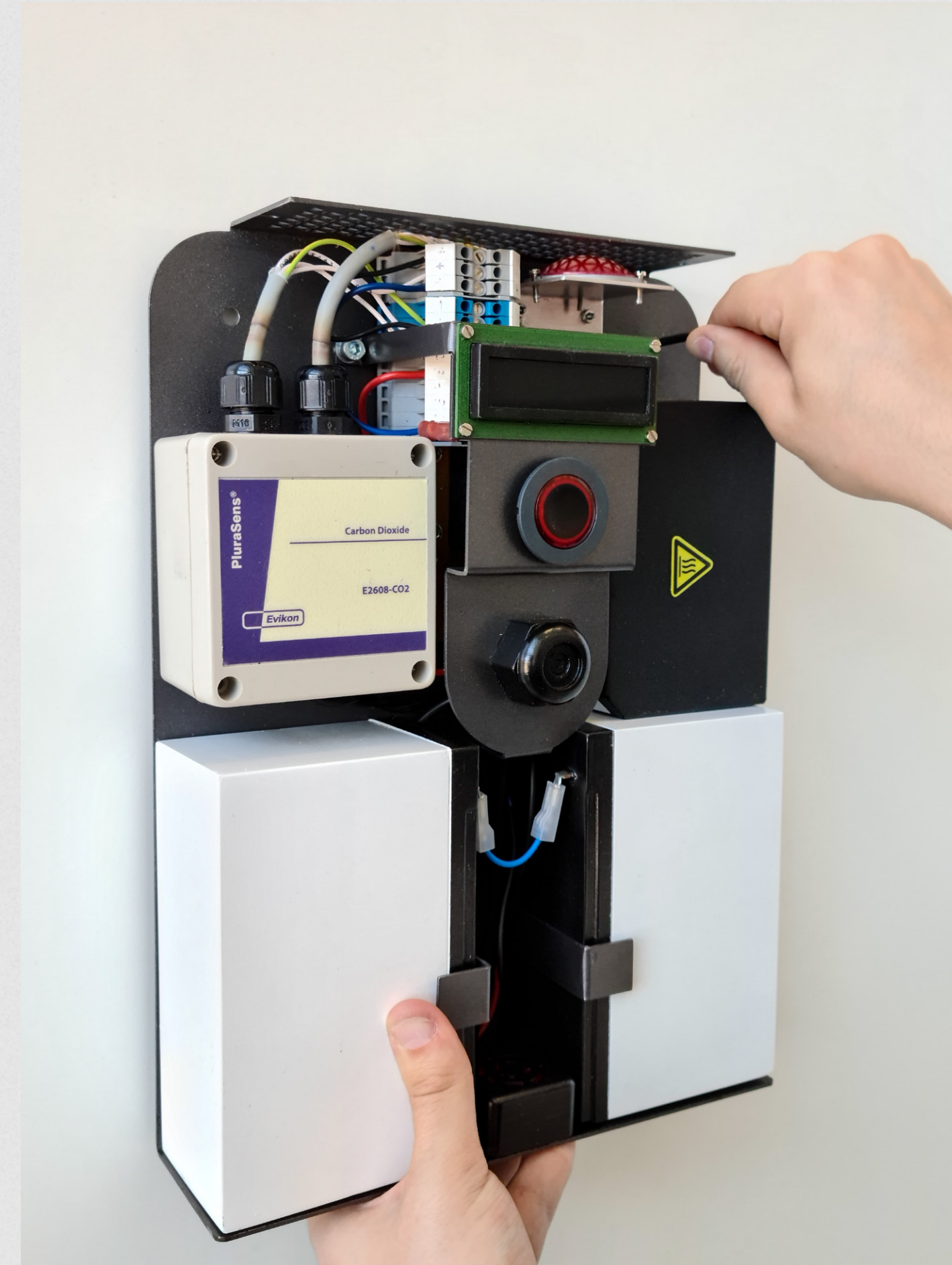
Kuva 40. Laitteen asentaminen seinään.
