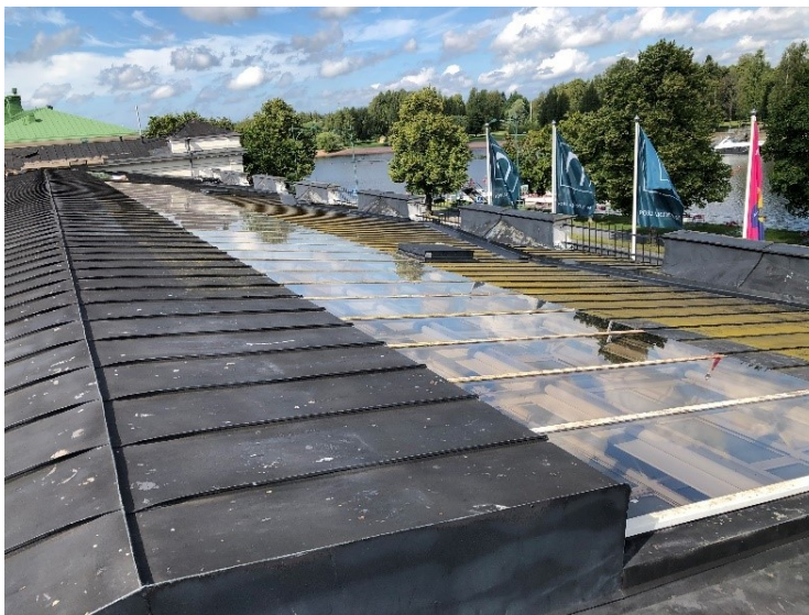
Kuva 22. Vesikaton kattoikkunat vuonna 2021. Kuva Ramboll Finland Oy.
