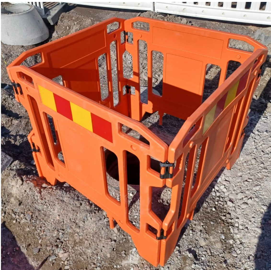
Kuva 14. Taitettava aita kaivotyöskentelyyn.
