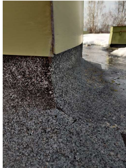
KUVA 20. Bitumikermi nostettu tarpeeksi korkealle
