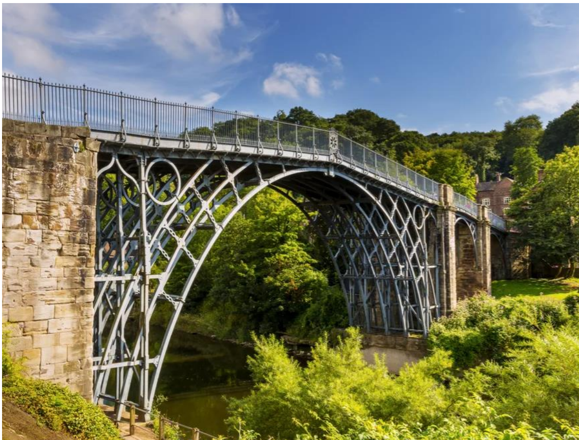
Kuva 6. Iron bridge on maailman ensimmäinen kokonaan raudasta tehty silta, joka on edelleen käytössä. Se on rakennettu vuosina 1776–1779. [20.]
