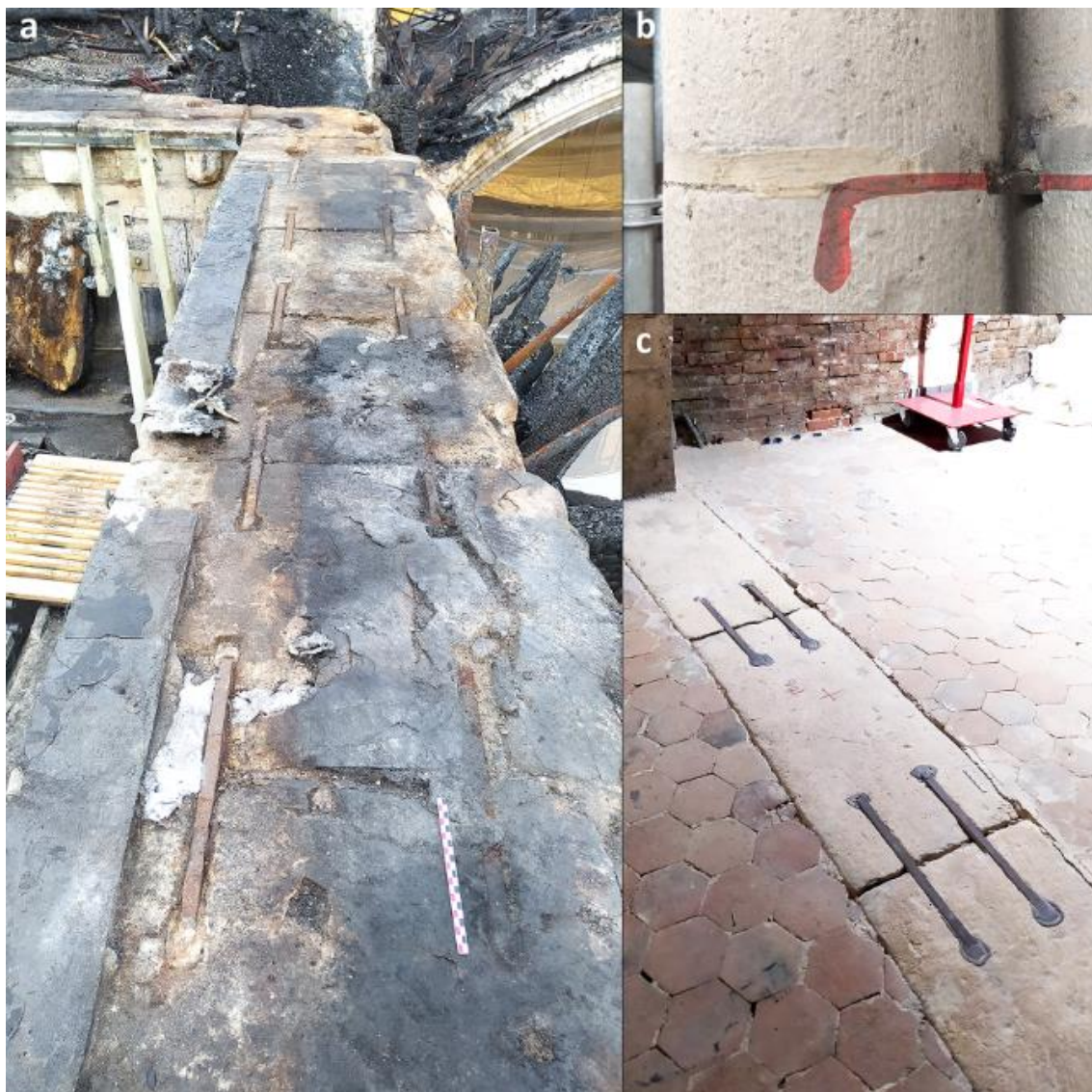
Kuva 5. Lähes 900 vuotta sitten rakennettu Notre-Damen katedraali tulipalon jälkeen. Siinä vahvistettiin mm. kantavat rakenteet rautavahvikkeilla. [18.]
