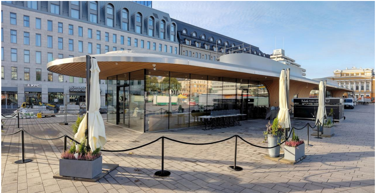
Kuva 1. Swecon suunnittelema toripaviljonki Turussa. Sen hoikat ja kevyet teräspilarit mahdollistavat avoimia tiloja ja pitkiä jännevälejä. [12.]
