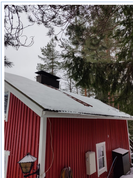
Kuva 13. Vesikatto, rakennuksen takapuolelta
