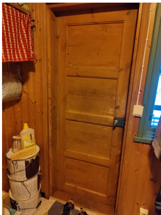
Kuva 32. Pesutilan ja pukuhuoneen ulko-ovi
