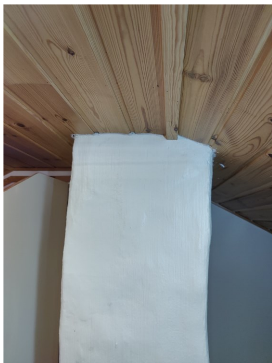
Kuva 26. Yläkerta piipun kattoliitos
