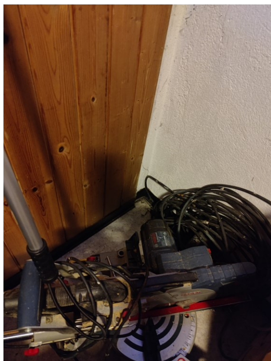
Kuva 34. Pesutilan ja pukuhuoneen lattia ja seinäliitos
