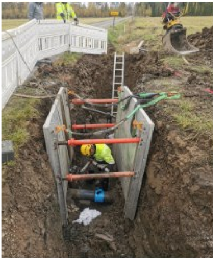
KUVA 1. Kaivantotuki asennettuna (Tukiainen Group 2023)
