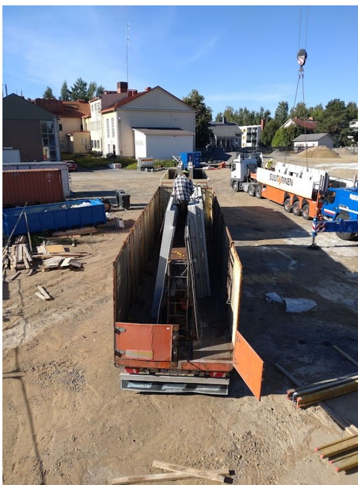
KUVA 6. Elementit työmaalla (Suhonen 2022)
