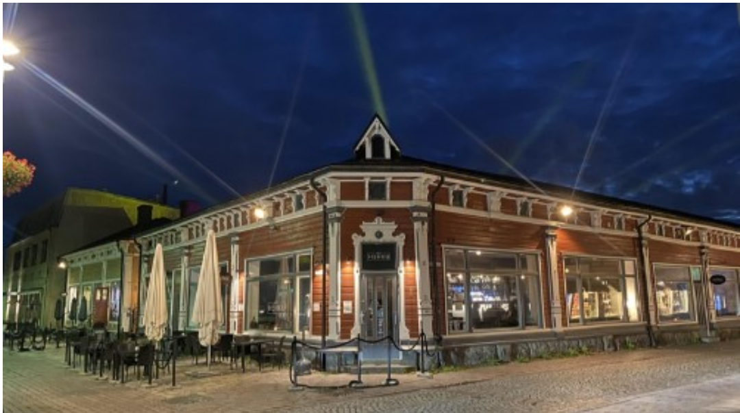
Kuva 5. Bar Hehkun julkisivu. Kuva: Joonas Lauronen.
