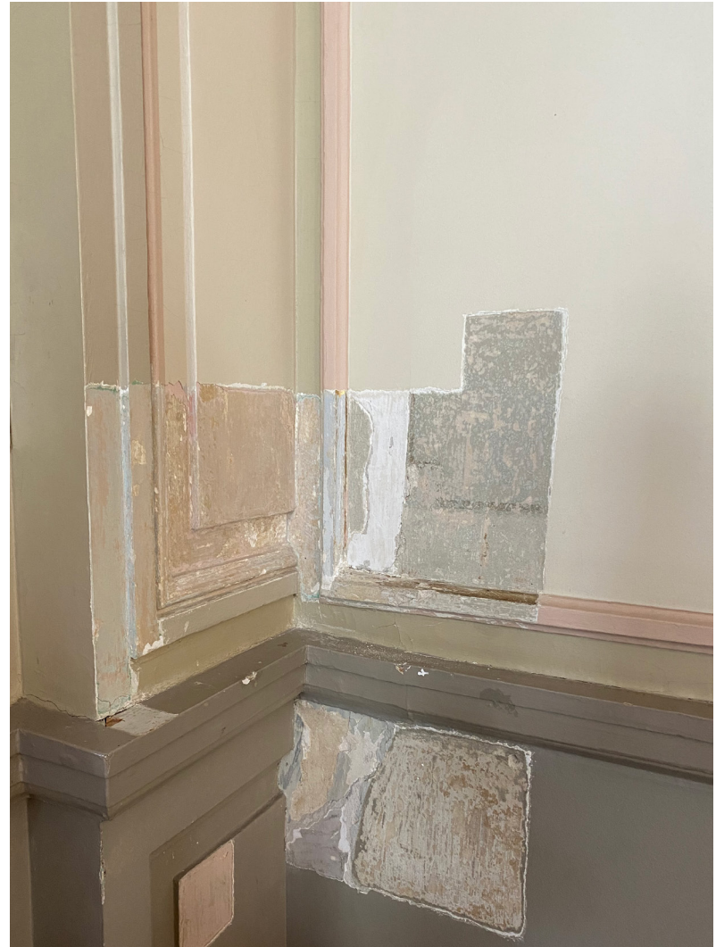
Kuva 25. Päälämpiön keskitilan pilasteri
