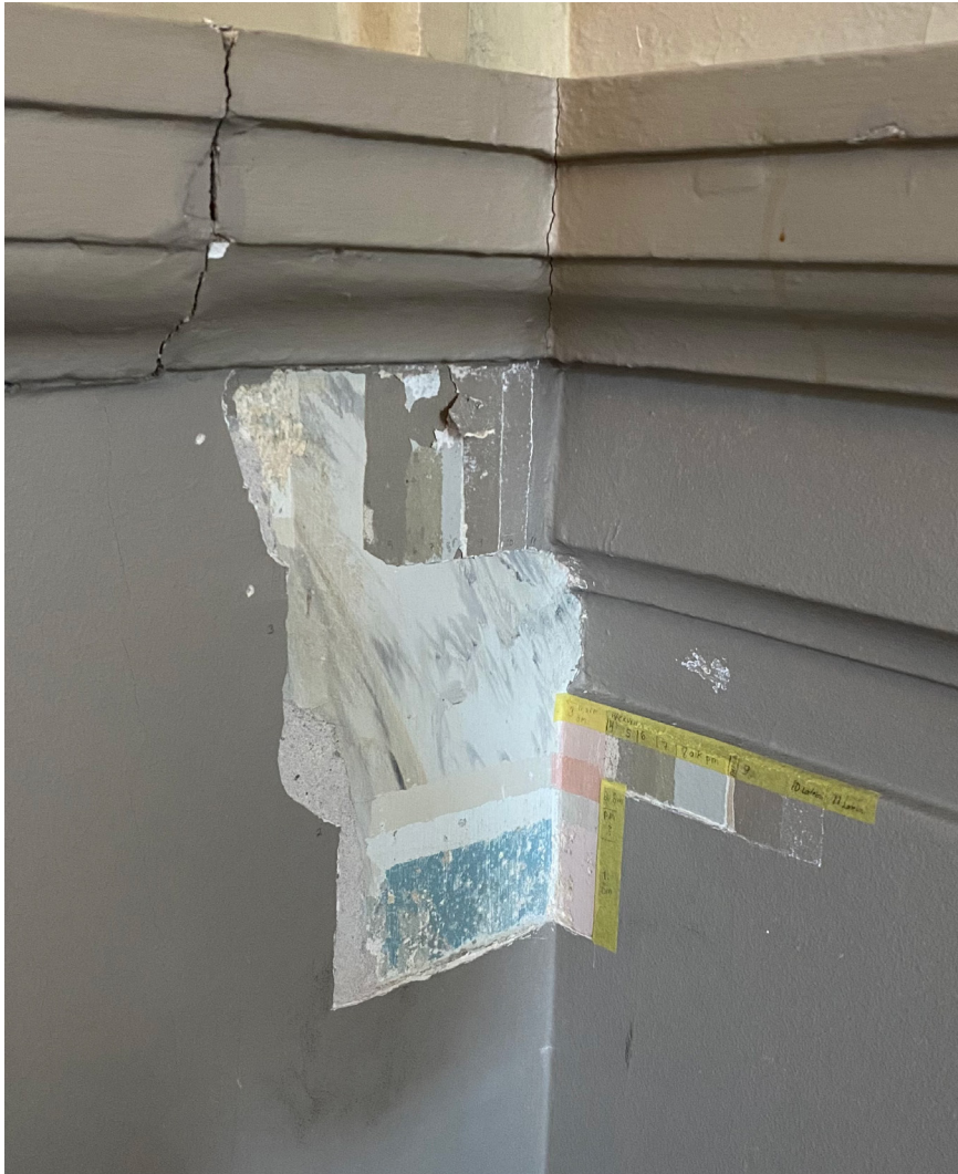
Kuva 24. Päälämpiön keskitilan alaseinä
