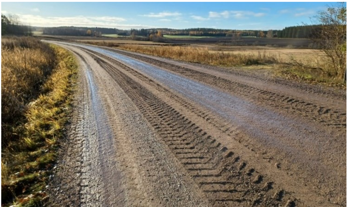
Kuva 19. Tien pinta ensimmäisen levityksen jälkeen (Rautalin 2022)
