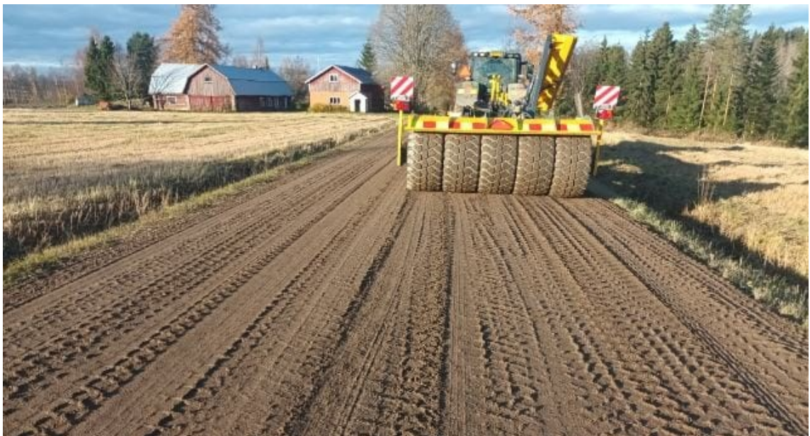
Kuva 22. Tien tiivistäminen lanauksen jälkeen (Ylikarjula 2022)
