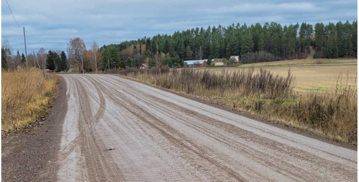
Kuva 21. Tien pinta kolmannen levityksen jälkeen (Ylikarjula 2022)
