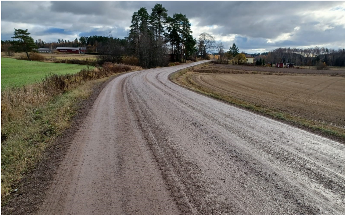
Kuva 20. Tien pinta toisen levityksen jälkeen (Rautalin 2022)
