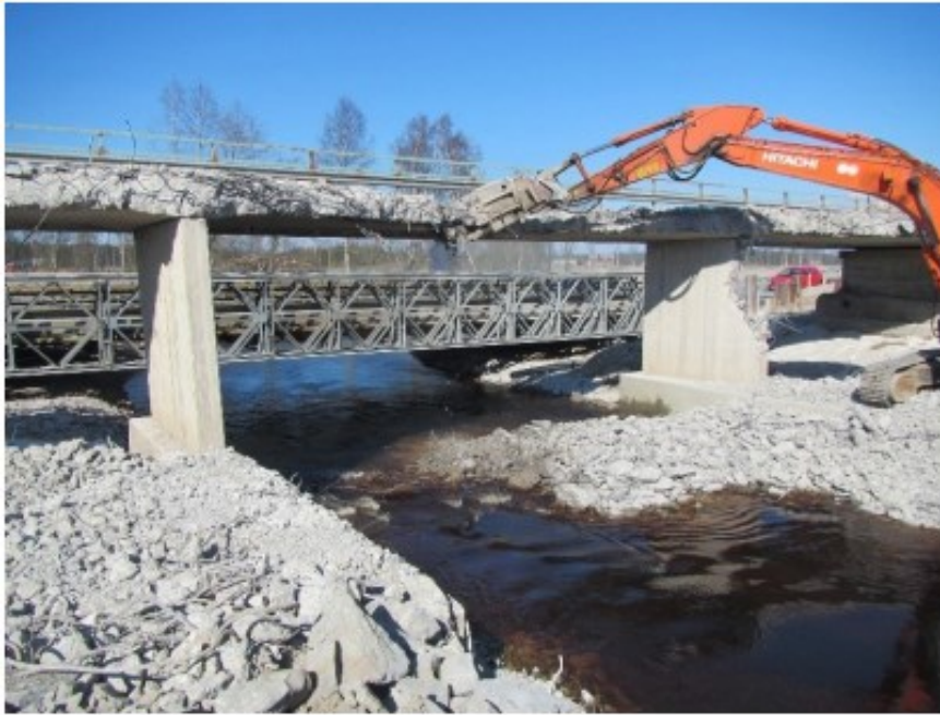
Kuva 6. Sillan kannen purkua puristusmurskaimella (Väylävirasto 2021a).
