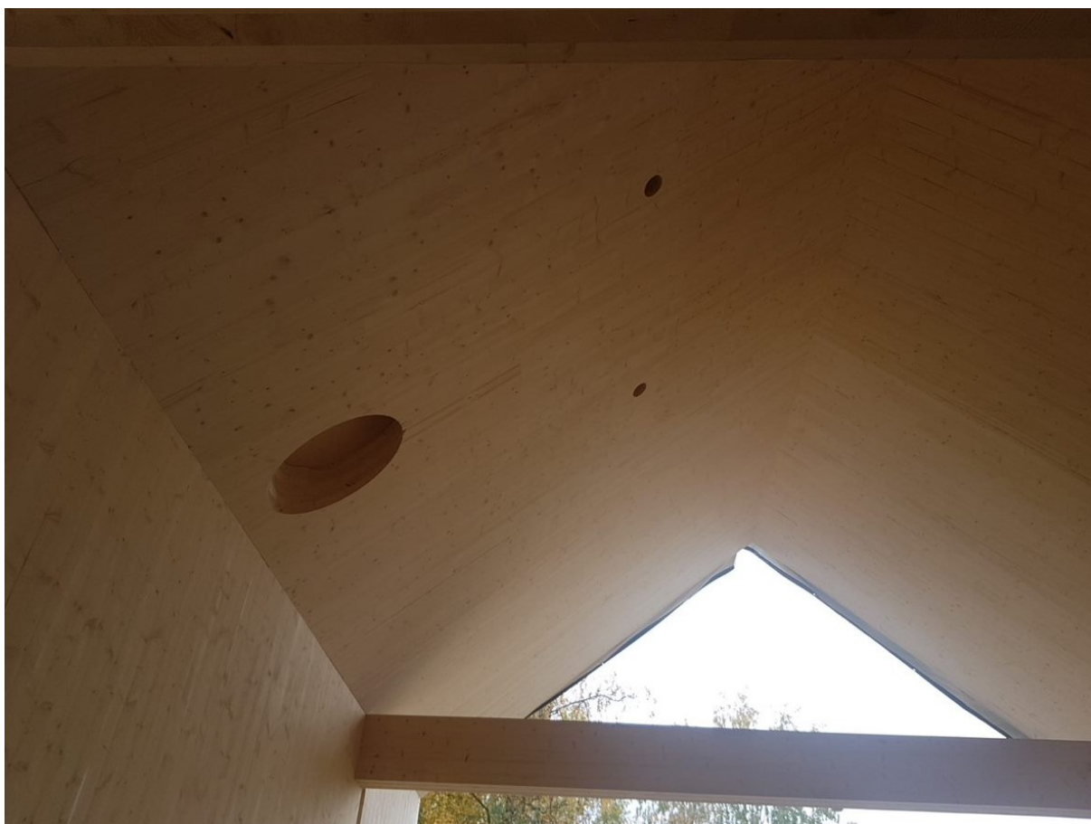
KUVA 3. CLT-ulkoseinä ja yläpohjat asennettuna (Pennanen 2020)
