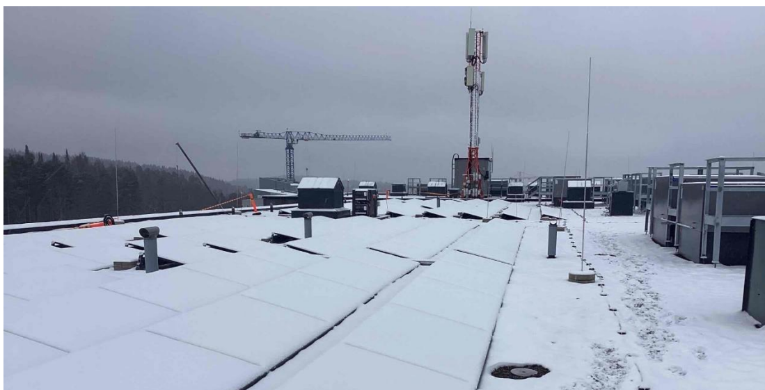
KUVA 7. Sairaalan vesikatto (Martikainen 2023.)
