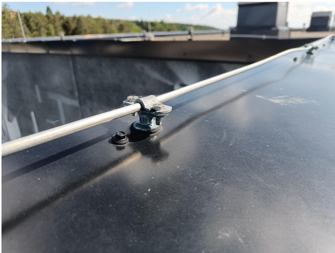
KUVA 6. Kattojohtimen asennus pellin läpi vaneriin, alumiininen pyöröjohtin (Martikainen 2023.)
